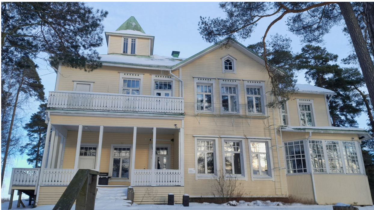
Kärkisaaren eteläosan kookas huvilarakennus Carlsro. Kuvissa erottuu länsipuoleinen julkisivu.
