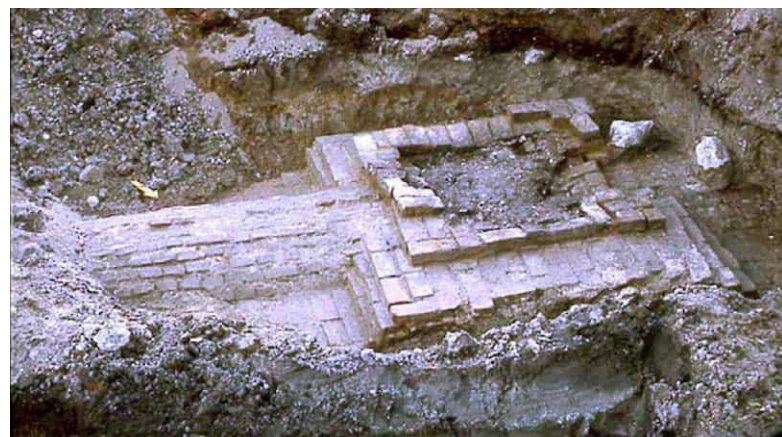
Yllä kurtiinimuurin ja pääportin perustukset, alla tarkastuskaivo ja tiilestä muurattu vesitunneli 1800-luvun alusta. 2004, Päivi Hakanpää, MV/RHO.
