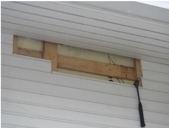
Kuva 8. Rakenneavaus laudoitetulta alueelta liimapuupalkin kohdalta
