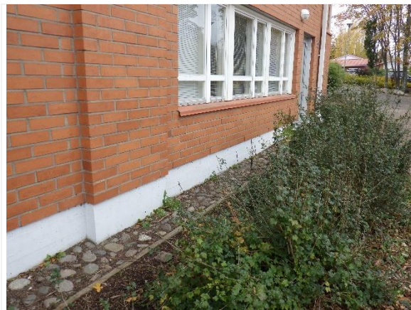
Kuva 3. Kuva pohjakerroksen 113 ulkopuolisesta sokkelirakenteesta
