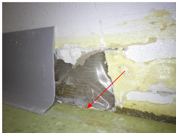
Kuva 21. Pieni vertaileva rakenneavaus tilan 201–209 päätyseinään. Muovikalvo loppuu välipohjan ontelolaatan reunaan
