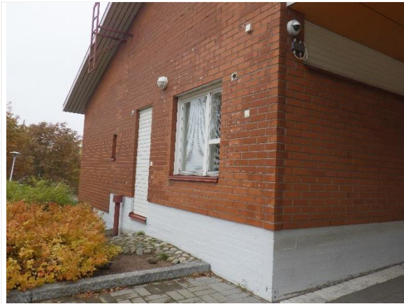
Kuva 1. Yleiskuva tilan 201–209 ulkopuolelta
