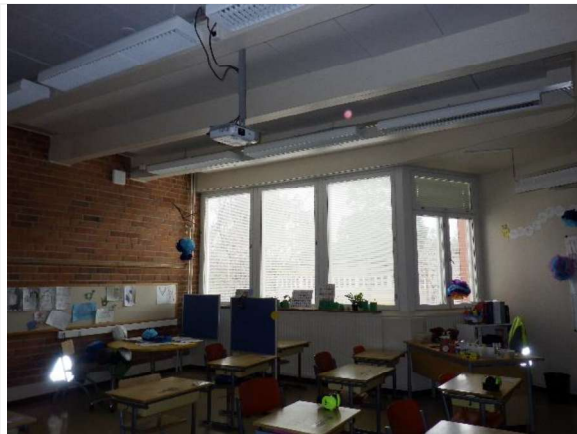
Kuva 16. Yleiskuva luokkatilan ulkoseinästä
