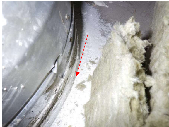
Kuva 24. IV-putkien läpiviennit lattiaan on tiivistetty
