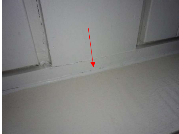
Kuva 27. Ikkunalistoituksessa halkeamia
