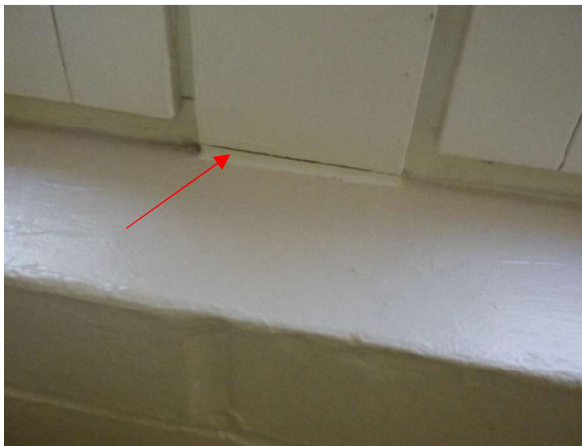
Kuva 1. Ikkunoiden välin ja ulkoseinän liittymä, jossa halkeama. Kyseisistä kohdista havaittiin ilmapuotoja. Levyä ei irrotettu. Rakenne on voitu tiivistää myös levyn takaa.
