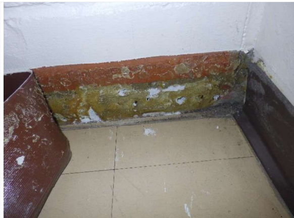
Kuva 8. Ruokalan 193 ja käytävän 166 välinen väliseinän ja lattian liittymää ei havaintojen mukaan ole tiivistetty. Väliseinätiili jatkuu lattiarakenteen alle
