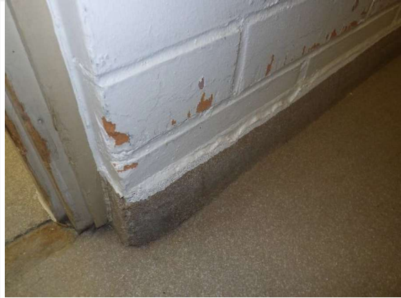
Kuva 6. Väliseinän liittymää tiivistetty (tilan 191 ja 185 välinen)
