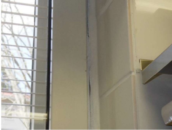
Kuva 5. Keittiön 185 ikkunan ja ulkoseinän liittymässä tiivistysnauha on hieman irti reunasta
