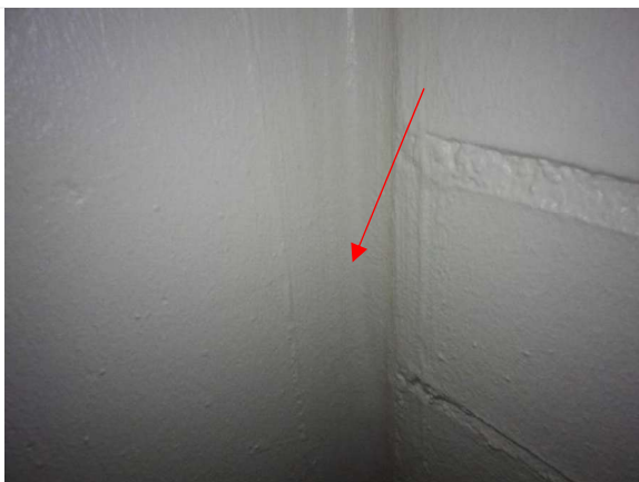
Kuva 30. Pilarin ja ulkoseinän liittymässä on vahvikenauha
