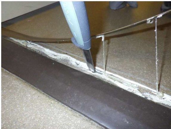
Kuva 7. Sos.tilan 188 ja TK 191 välinen lattian liittymä ei ole tiivis
