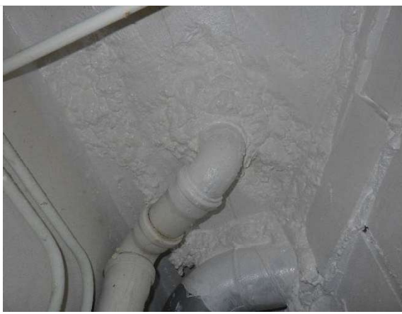
Kuva 96. Käytävän 304 sähkökaapista ei havaittu ilmayhteyttä ullakolle.
