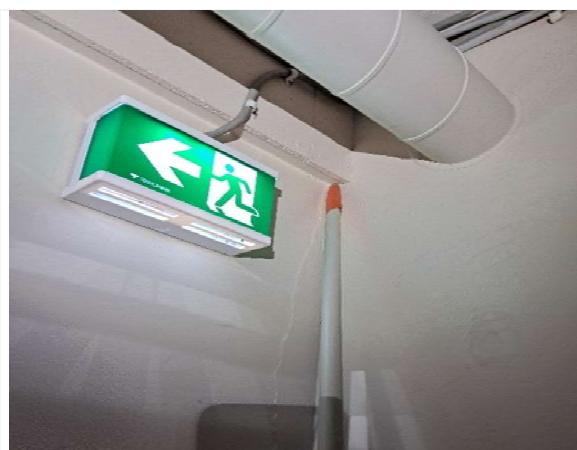
Kuva 74. Vuotopaikka sähköjohdon läpiviennistä.
