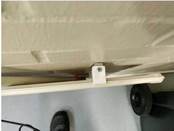
Kuva 51. Patterin kannakkeesta havaittiin ilmapuotoa.
