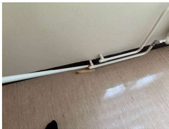
Kuva 84. Ilmavuotopaikka tilassa 212.
