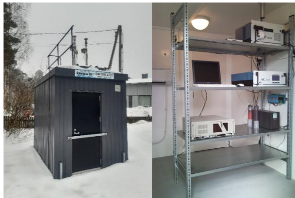
Kuva 2. Mittauskoppi ulko- ja sisäpuolelta.
