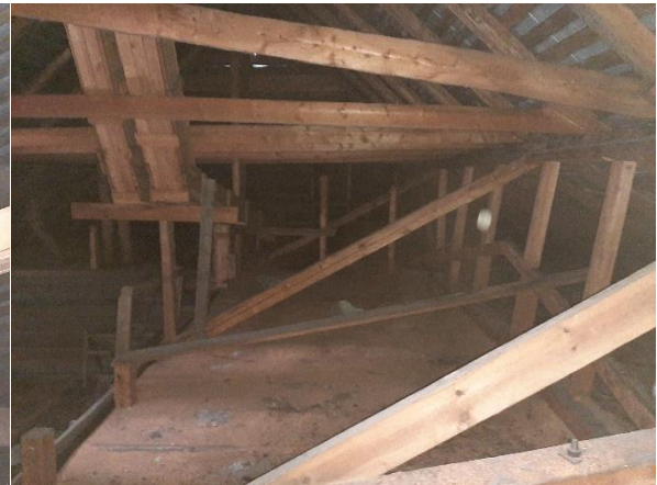
Yleisesti puurakenteissa ei havaittu merkkejä vaurioitumisesta
