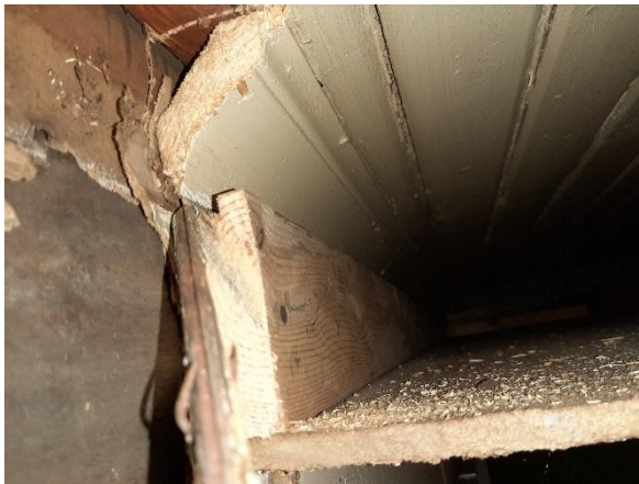
Vanha lautakatto on jätetty uuden alakaton alle
