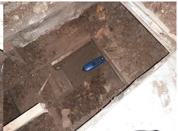
Rakenneavauksesta mitattiin puurakenteiden kosteuksia. Kosteudet noin 15 p- %
