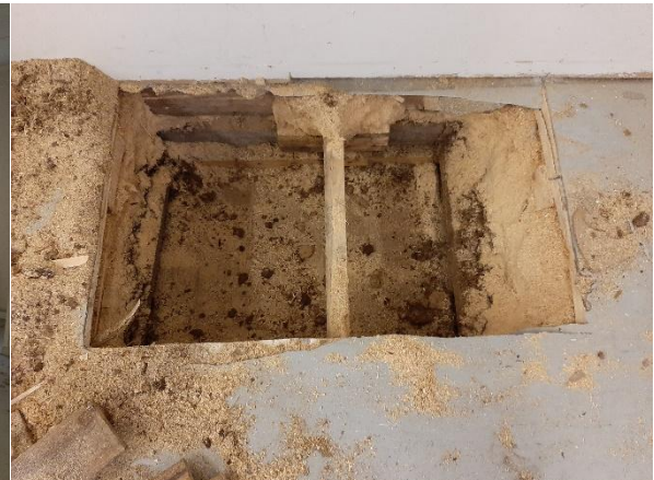
Rakenneavauksessa ei havaittu viitteitä vaurioista
