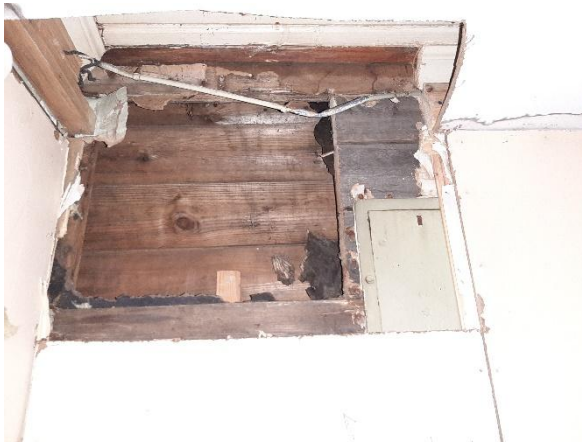
Sisäverhouslevyn takana tuuletusaukko. Rakenteessa ei havaittu vaurioitumista
