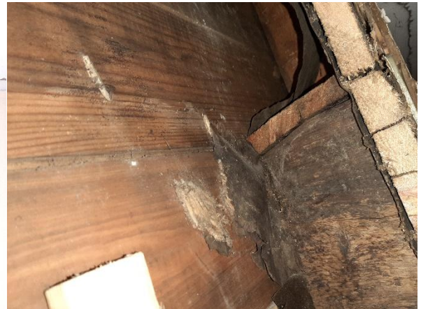
Rakenneavauksessa RA.17-US ei todettu merkittävää vaurioitumista. Rakenteen lämmöneristeenä on mineraalivilla
