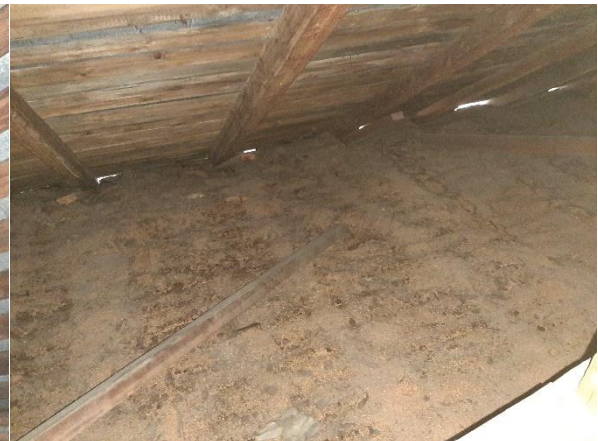
Lämmöneristeenä purua
