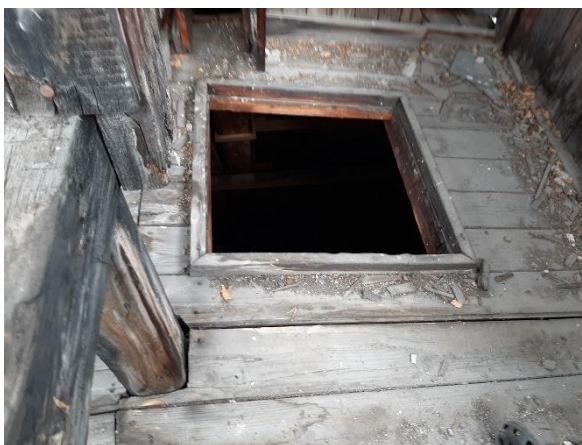
Ilmanvaihtotornin kulkuaukossa ei ole erillistä luukku. Torni on katettu peltikatteella
