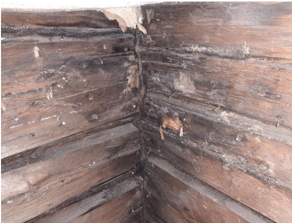
Ulkonurkassa hirsi tummunutta, ei kuitenkaan lahovaurioitunutta sisäpinnasta
