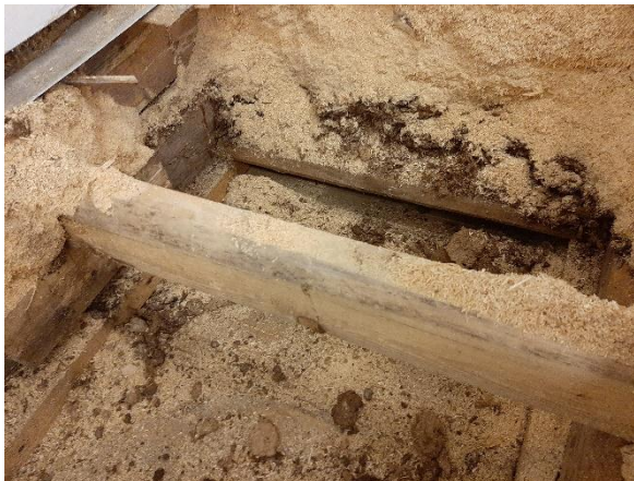
Purueristeet ovat kuivat ja puurakenteissa ei avauskohdassa lahovaurioitumista
