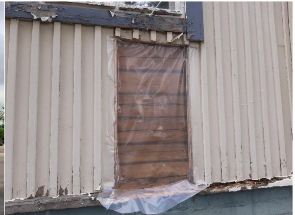
Julkisivuun tehty rakenneavaus RA.08-US
