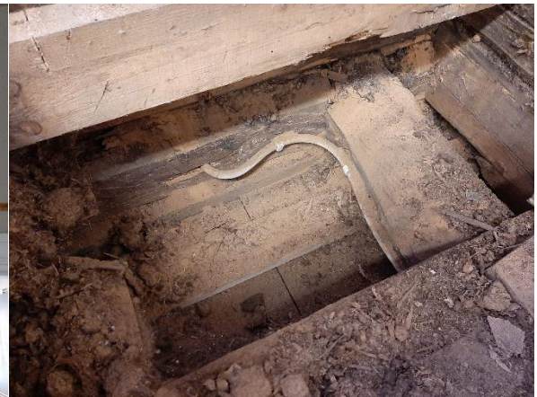
Rakenteissa kulkevia sähköjohtoja
