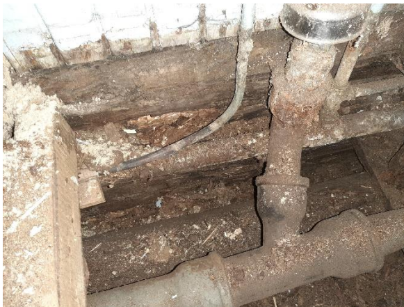
Lattiarakenteessa oleva viemäriputki
