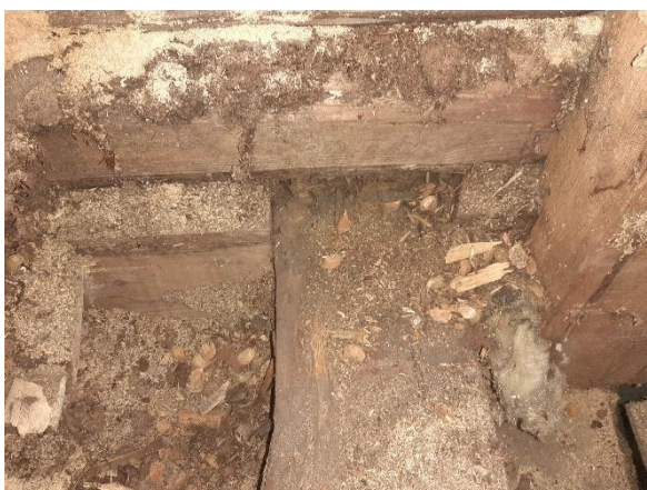
Alaohjapalkin liitos sokkeliin ja hirsiseinään. Avauksissa RA.06 ja RA.07 ei havaittu lattian puurakenteissa lahovaurioitumista
