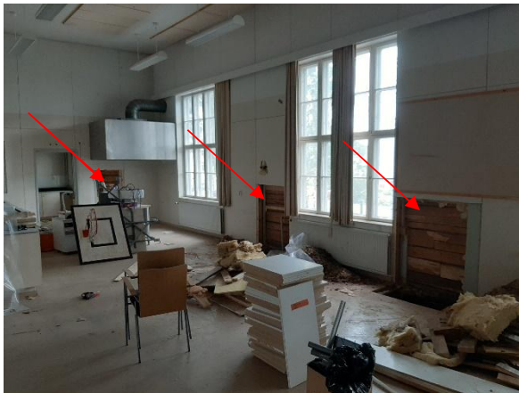
Ulkoseinärakenteen rakenneavaus kohdat RA.13-15-US
