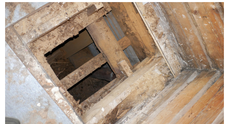
↑ ↑ Kellarin alustilan yläpuoliset rakenteet kannattavia graniittilohkareista pinottuja tukirakenteita. Amoy 2020
