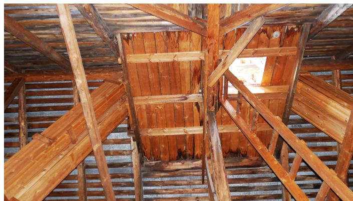
← Rakennusaineiset IV-kanavat nousevat kellotornimaiseen tuuletuskammioon, joka on keskellä vesikattoa. Amoy 2020
