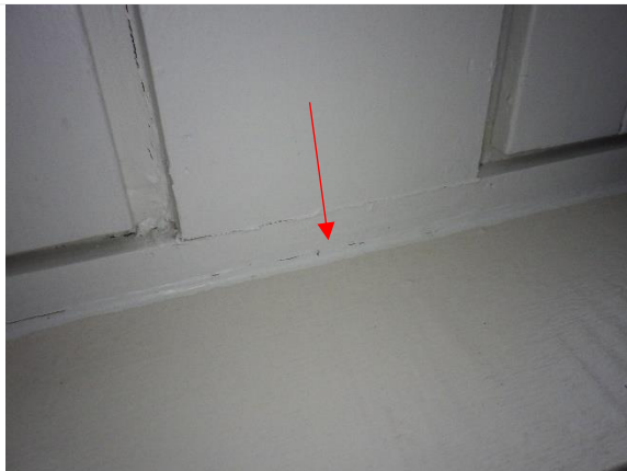
Kuva 27. Ikkunalistoituksessa halkeamia
