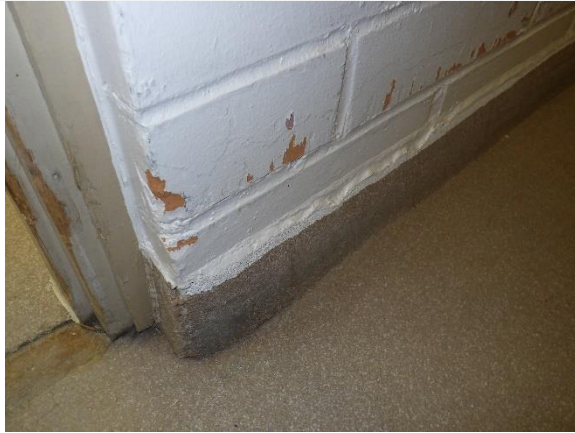
Kuva 6. Väliseinän liittymää tiivistetty (tilan 191 ja 185 välinen)
