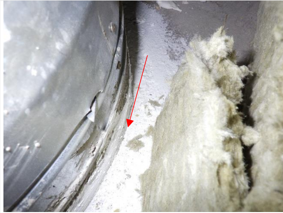
Kuva 24. IV-putkien läpiviennit lattiaan on tiivistetty
