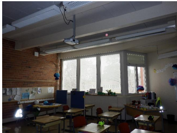
Kuva 16. Yleiskuva luokkatilan ulkoseinästä
