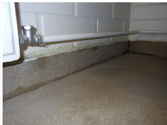
Kuva 9. Sos. tila 188 ulko- ja väliseinän nurkka. Akryylimassan liittymiä tiivistetty
