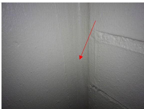
Kuva 30. Pilarin ja ulkoseinän liittymässä on vahvikenauha
