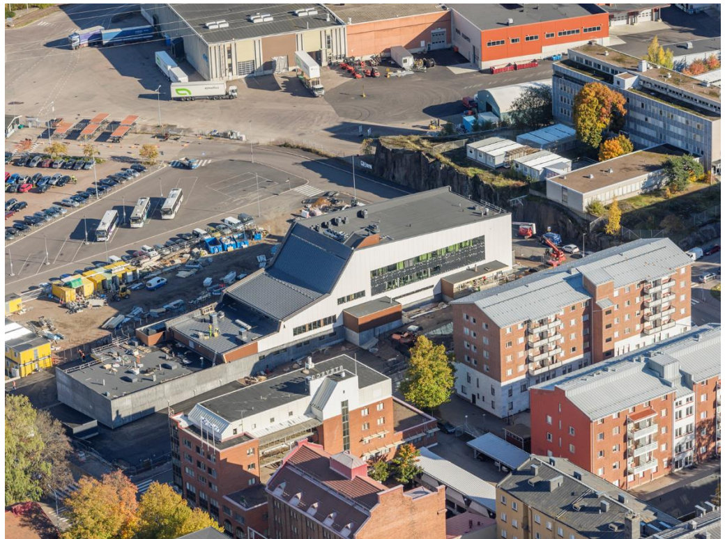
Ilmakuva: Etualalla uusi poliisitalo ja sen takana linja-autojen ja ajoneuvojen pysäköimiseen käytettyä avointa asfaltoitua aluetta. Oikealla erottuu sittemmin purettu vanha poliisitalo.
