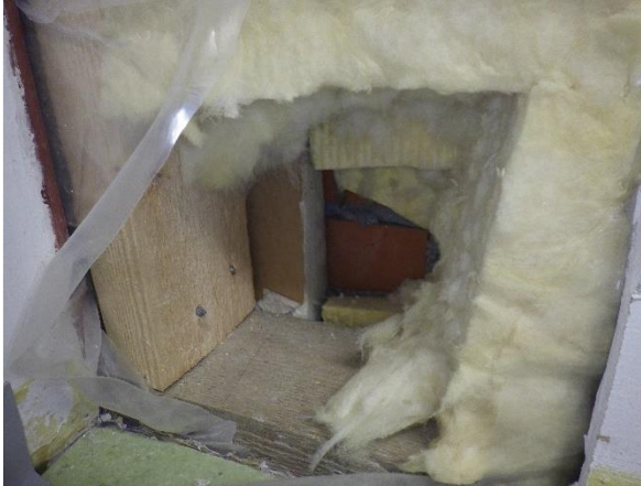
Kuva 6. Rakenneavaus ulkoseinän nurkkaan, jossa teräspilari vasemmalla
