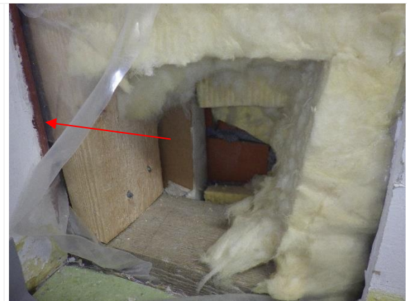
Kuva 20. Rakenneavaus tilan 210 ulkoseinänurkkaan. Nuolen osoittamassa nurkassa teräspilarin takana havaittiin mineraalivillaa eristeenä
