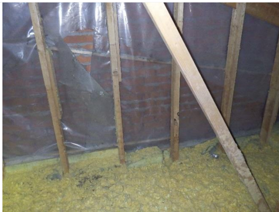
Kuva 28. Rakennuksen länsipääty, jossa ulkoseinän muovia on jatkettu yläpohjatilaan
