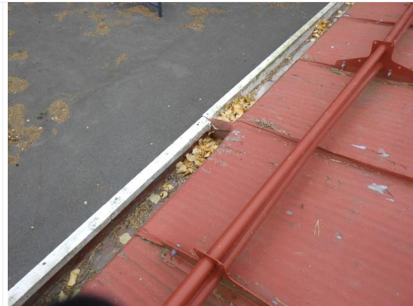
Kuva 33. Sadevesikouruissa havaittiin vain vähäisesti lehtiä ja roskia
