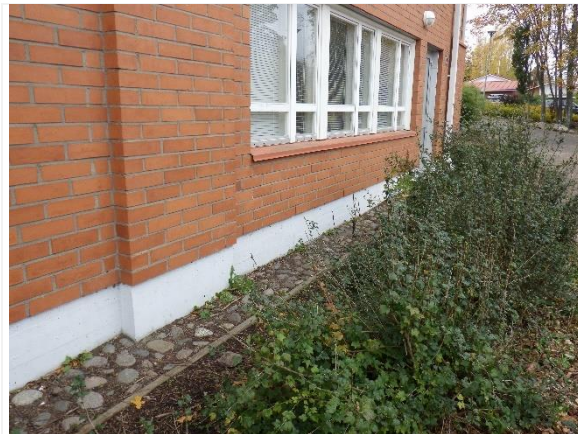
Kuva 3. Kuva pohjakerroksen 113 ulkopuolisesta sokkelirakenteesta
