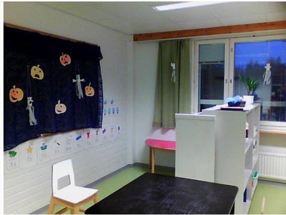
Kuva 17. Tila 210 ulkonurkkaa kuvattiin lämpökameralla (viereinen kuva)
