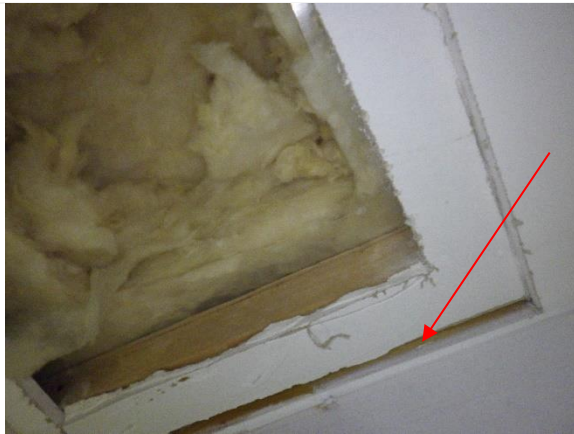
Kuva 26. Yläpohjan muovikalvo päättyy liimapuupalkin sisäpintaan
