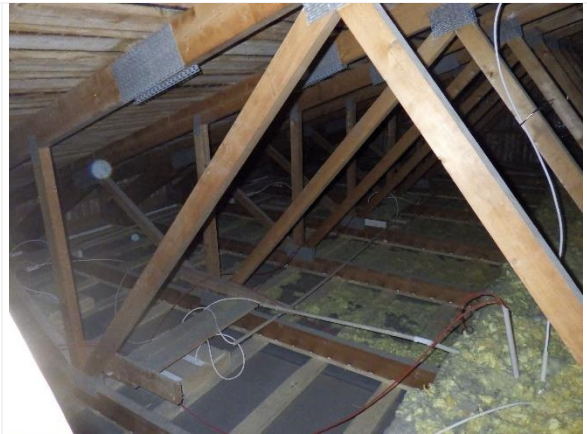
Kuva 27. Yleiskuva yläpohjasta (eristämätön kohta ulkokatos)
