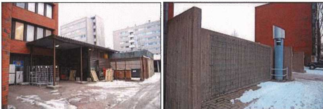
Kuva 5-19 Sisäpiha sekä sitä reunustava betoniaita.
