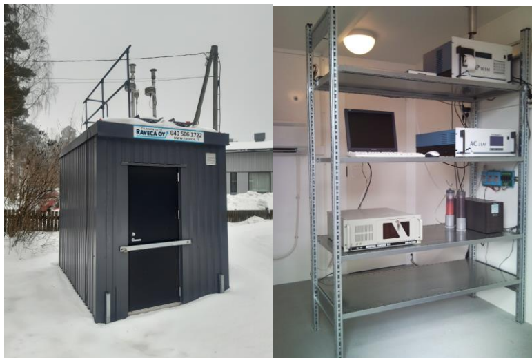
Kuva 3. Mittauskoppi ulko- ja sisäpuolelta.
