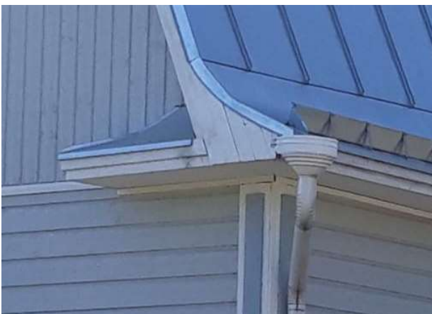
Kate on uusittu noudatellen perinteisiä rakennustapoja.
