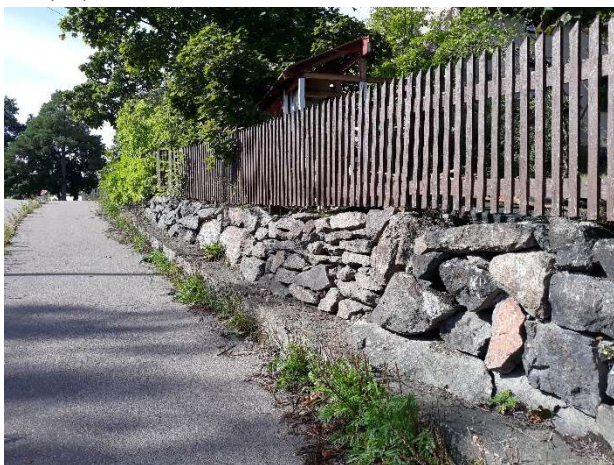
Luonnonkivimuuri on luonnollinen ja miellyttävä isoinakin pintana. Kuvassa tukimuuriin on yhdistetty puuaita.
