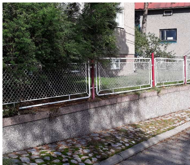
1950-luvun matala metalliaita on yhdistetty tukimuuriin.
