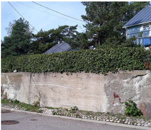
Korkea umpinainen betonimuuri tuottaa epämiellyttävää katu ympäristöä.
