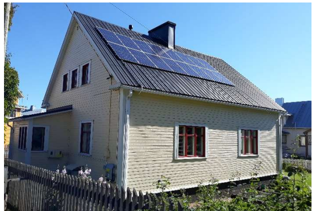
Aurinkopaneelit asennettu lappeen suuntaisesti. Kadun puoleisella lappeella katteen väristä poikkeavat paneelit erottuvat katukuvassa.
