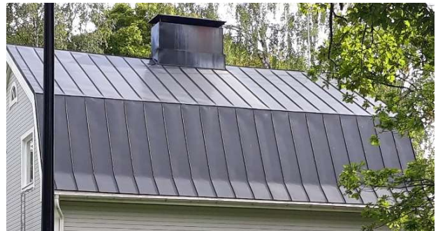
Katteesta on sen uusimisen myötä hävinneet alueen mansardikatoille tyypilliset yksityiskohdat, kuten jalkarännit.
