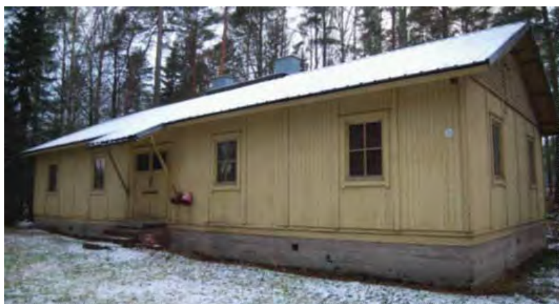
Parakkirakennus (nro 21). Kuva Sanna Ihatsu.
