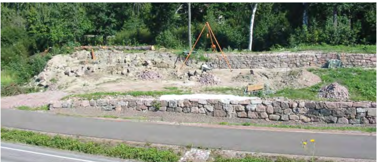
Kymintien varren vastamuurin korjaustyö vuonna 2007. Kuva Sanna Ihatsu.
