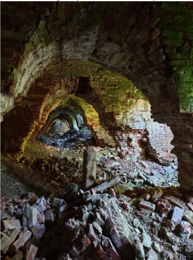
Kuva 4.2. Osittain romahtaneet kasemattiholvit ovat lepakoiden levähdyspaikkoja. Niiden katossa ja seinissä on paljon lepakoille sopivia tiilenrakoja ja pohjalta löydettiin lepakoiden ulosteita.
