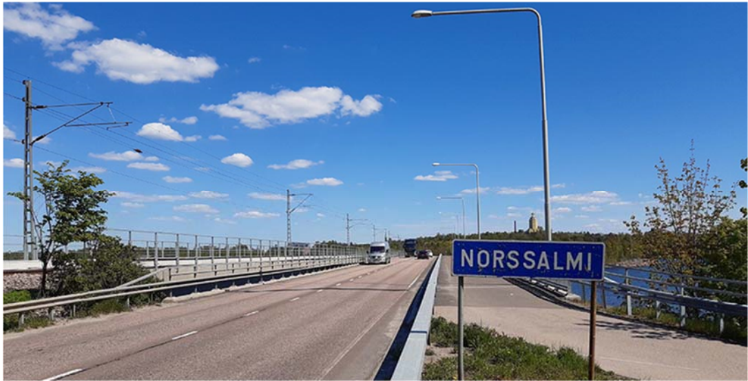
Norssalmen silta yhdistää Kotkansaarta ja Hirssaarta. Merituulentiellä sekoittuvat sataman raskasliikenne sekä paikallinen henkilöautoliikenne. Lisäksi samaa liikennekäytävää käyttävät satamaan kulkevat raskaat tavarajunat sekä alueen pyöräilijät ja jalankulkijat.
