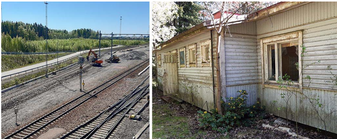
Kuvateksti: Uutta ja vanhaa Kotolahdessa. Vasemmalla käynnissä Kotolahden ratapihan laajennustyö. Satama-alueen käyttöön saadaan ratapihalle 5 lähes kilometrin pituista uutta raidetta. Oikealla tyhjäksi jäänyt rakennus Venekalliontien varrella.
