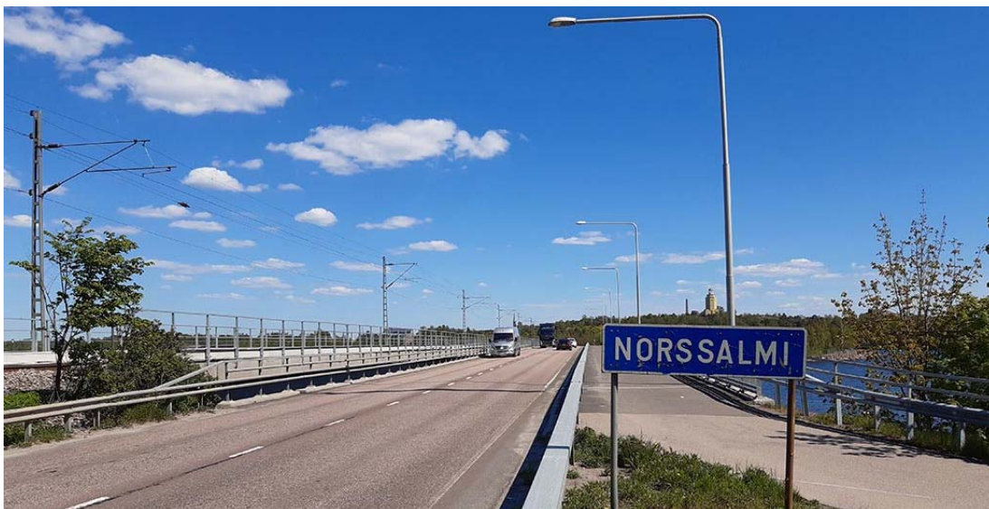
Kuvateksti: Norssalmen silta yhdistää Kotkansaarta ja Hirssaarta. Merituulentientä sekoittuvat sataman raskasliikenne sekä paikallinen henkilöautoliikenne. Lisäksi samaa liikennekäytävää käyttävät satamaan kulkevat raskaat tavarajunat sekä alueen pyöräilijät ja jalankulkijat.
