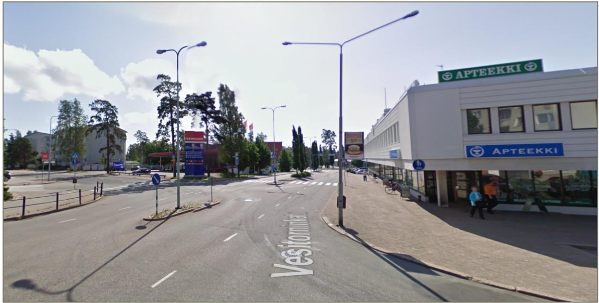
Kuva 12. Vesitorninkadun länsipuolen yhdistetty pyörätie ja jalkakäytävä on alimitoitettu, eikä vastaa mm. erotelutarpeiltaan tarkoitustaan (kuva: Google Street View).
