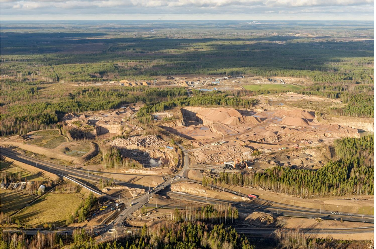
ilmakuva vt7:ltä pohjoiseen
