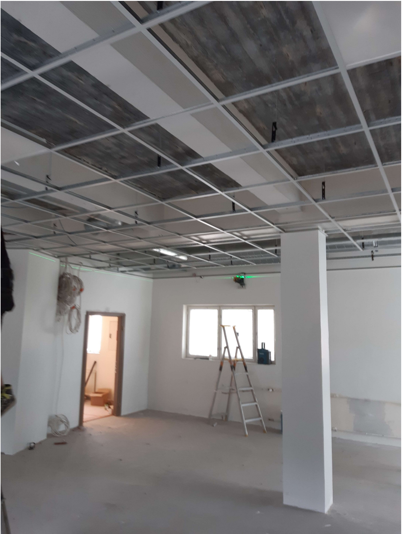
Kuva 5. Uutta alakattorunkoa.
