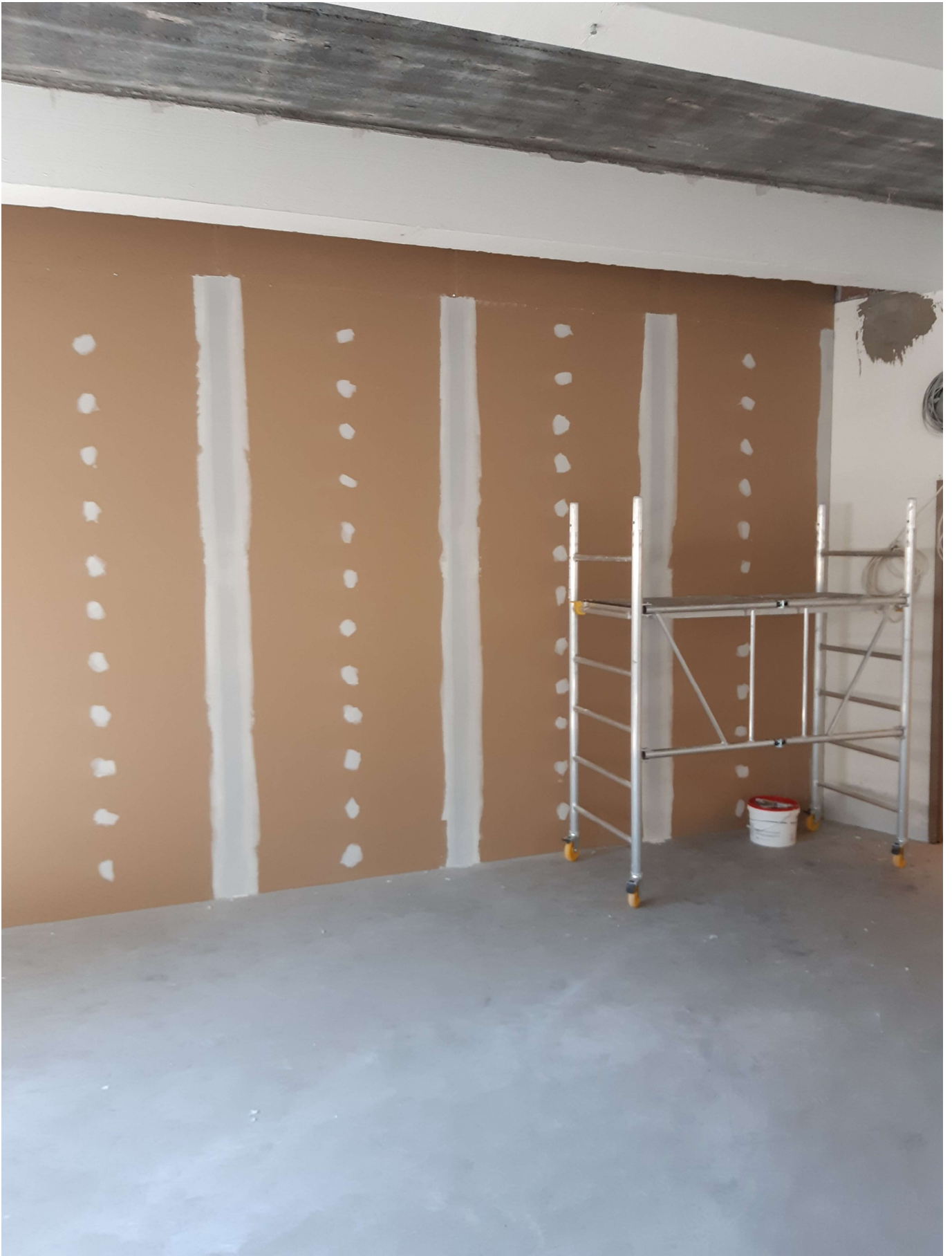
Kuva 4. Uutta väliseinää.
