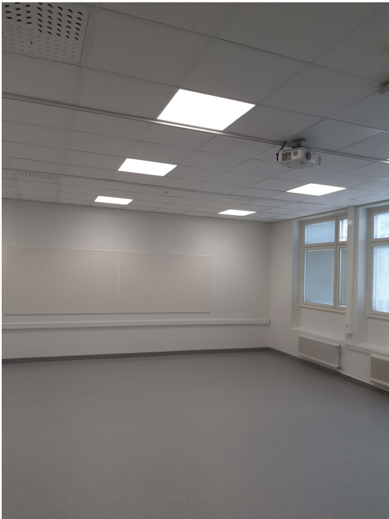
Kuva 7. Uusi lattiapinnoite, julkisen tilan homogeeninen muovimatto. Kiinnityspinnat ja alakattolevyt uusia, materiaalivalinnassa kiinnitetty huomiota hajuttomuuteen.
