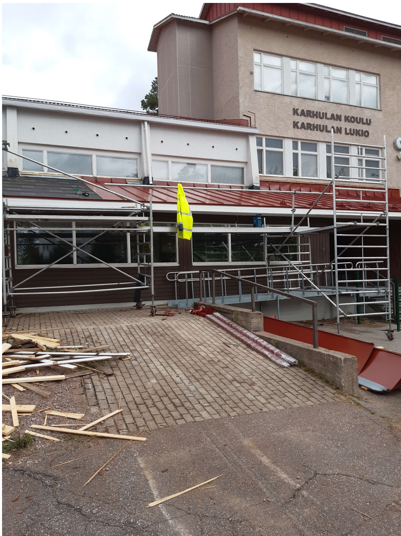
Kuva 9. Uutta vesikattopintaa, konesaumattu peltikatto. Vasemmassa reunassa näkyy myös uusi aluskate.
