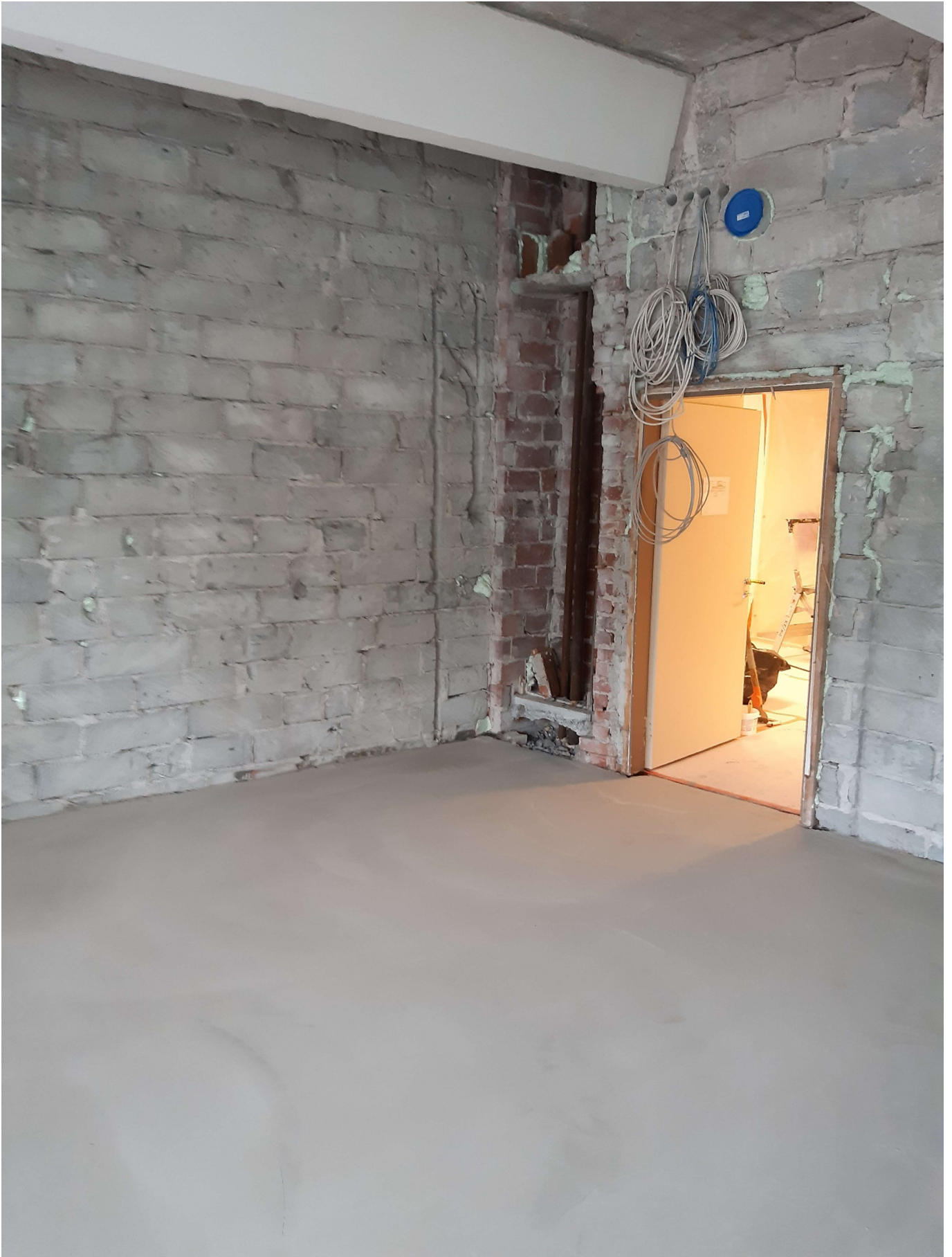
Kuva 3. Luokkatila purkutöiden jälkeen. Lattia tasoitettu.
