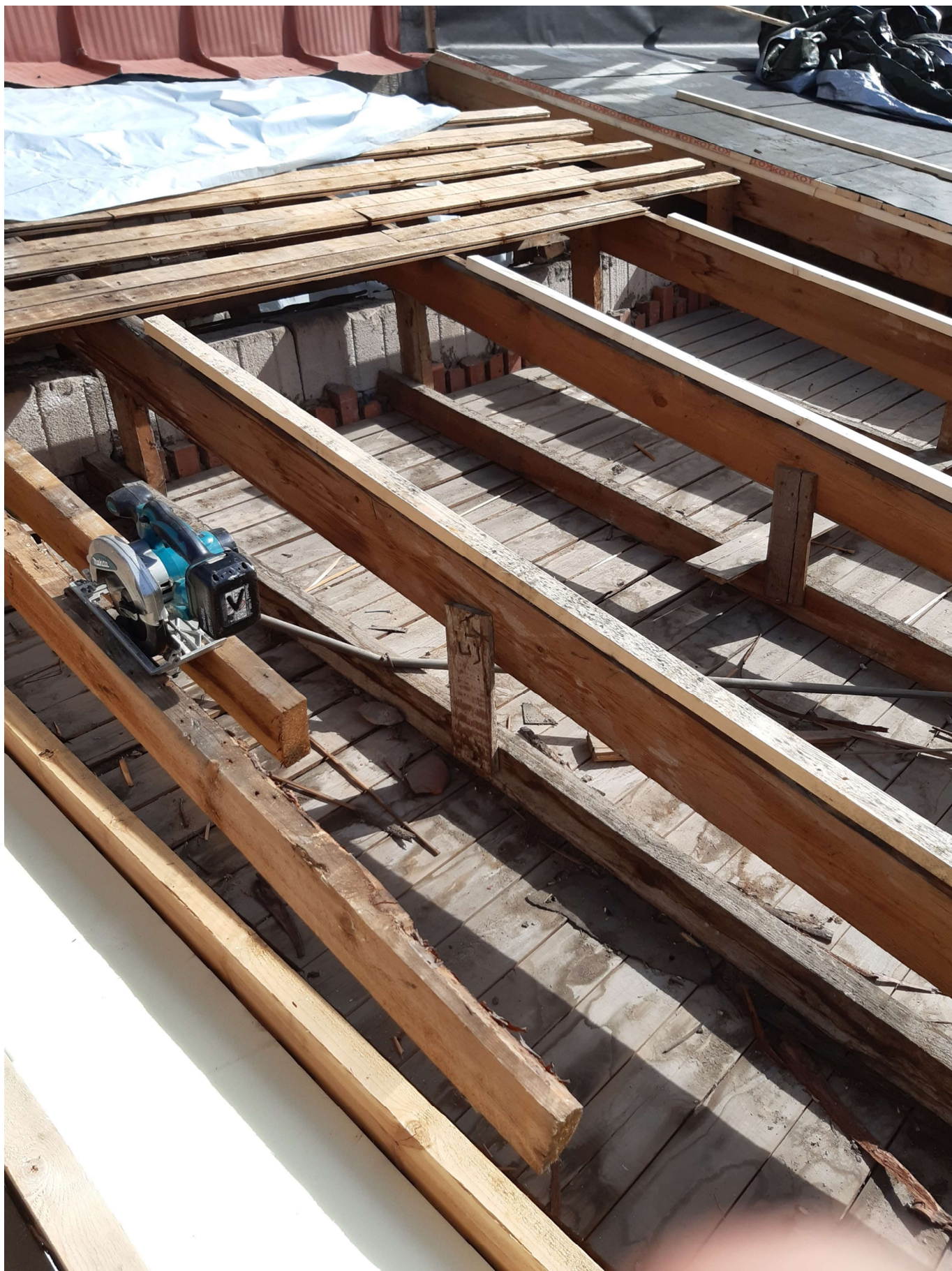
Kuva 8. Ruokalan vesikaton purkutyötä. Vesikaton lämpöeristeet uusittiin kokonaisuudessaan.
