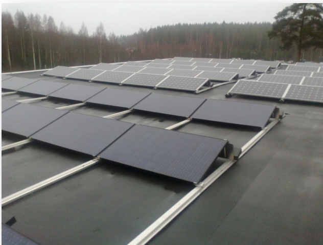
Kuva 10. Jälkiasennettu aurinkopaneelijärjestelmä Lappeenrannan teknillisen yliopiston katolla. Paneelit ovat kallistuskulmassa 15°. Kuva © Esa Partanen, Kotkan kaupunki, tammikuu 2014.
