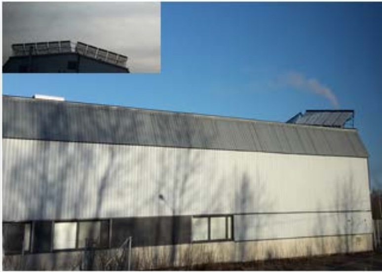
Kuva 13. Kotkassa Hyvinvointikeskus Huuman katolla oleva 14,6 kW:n aurinkolämpöjärjestelmä. Järjestelmän keräimet ovat katon reunassa melko jyrkässä kulmassa siten, että ne ovat etelän ja lounaan suuntiin. Keräimet (10 kpl) ovat ns. tyhjiöputkikeräimiä. Kuvat: Esa Partanen, Cursor Oy, 3/3015
