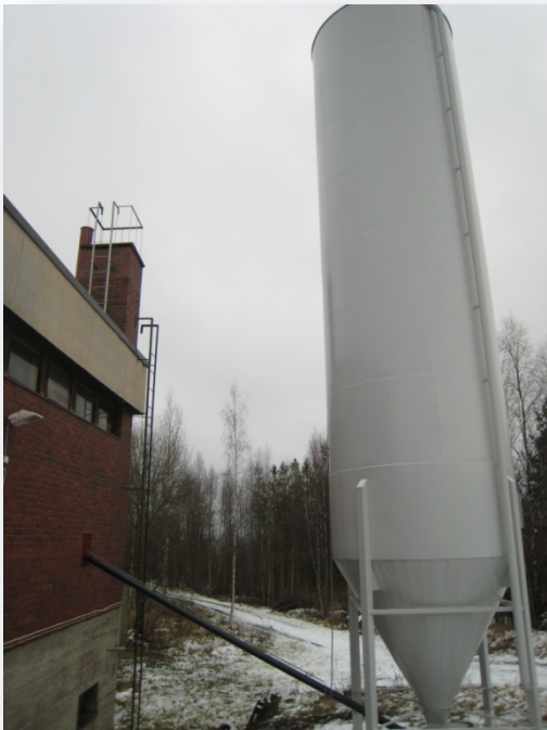
Kuva 7. Hotelli Leikarin pellettilämmitysjärjestelmän 70 m 3 :n varastosilo. Itse 700 kW:n pellettikattila on kuvassa näkyvässä tiilirakennuksessa. Pellettikattilan piippu on tiilisen piipun vieressä näkyvä kapea piippu. Varastosilo täytetään puhaltamalla pelletit kuljetusauton letkulla silon yläosasta. Kuva © Esa Partanen / Kotkan kaupunki, marraskuu 2014.
