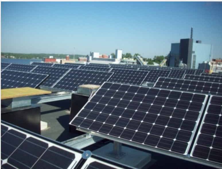
Kuva 12. Kotkan Energia Oy:n toimitalon katolla oleva 12,5 kW:n aurinkosähköjärjestelmä. Kuva (c) Kotkan Energia Oy.
