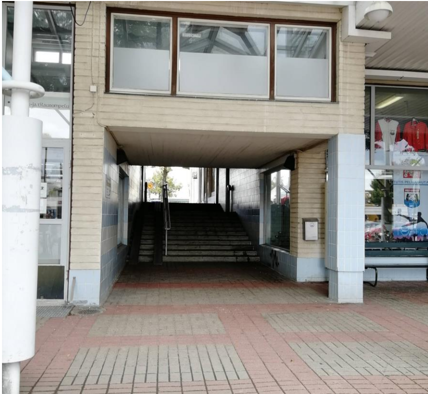
REITTI TORILTA KULKI LIIKERAKENNUKSEN PORTAIKON LAPI.
