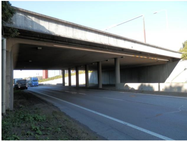
Kuva 20: Karhulantien rs.:n itäreunan vieressä kulkeva elementtipalkisto, jonka varassa on 2 kpl kaukolämpöputkia (Kuva Karhulantien rs. siltakortista 2014).
