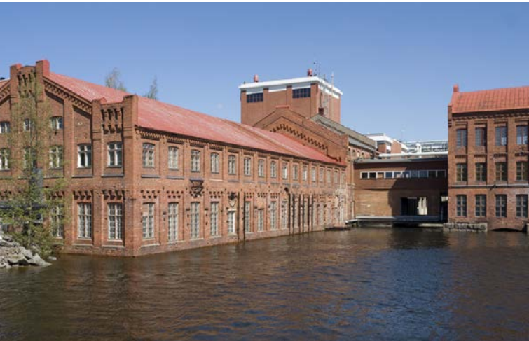
Kuusaansaaren vanha paperitehdas vuodelta 1891. Oikealla vuonna 1897 rakennettu sähkösentraali ja taustalla klooridioksidilaitos vuodelta 1995.
