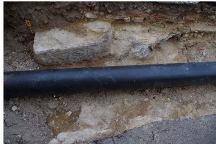
Ammuskellarin kivistä ja tiilestä muurattuja rakenteita, joiden lävitse kaukolämpökaivanto oli vedetty.
