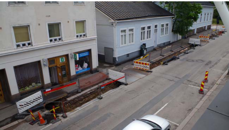
Kauppakadun kaukolämpöjohtokaivanto.
