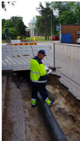
Jukka Saarela mittaa- massa kaivannon rakenteita ja kerroksia.
