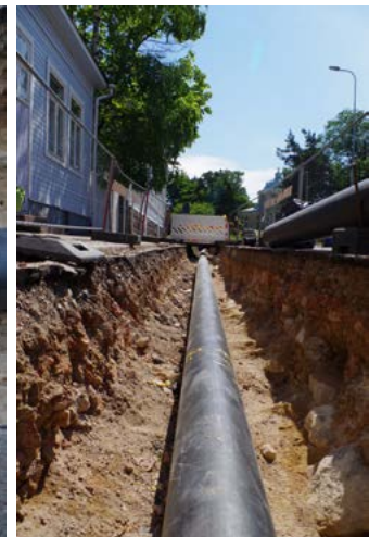
Kaivanto oli täynnä tiilensekaista purkujätettä, joka värjäsi koko ojan oranssinpunaiseksi. Oikealla kaivannon alaosan seinämässä ammuskellarin kivistä perustusta.
