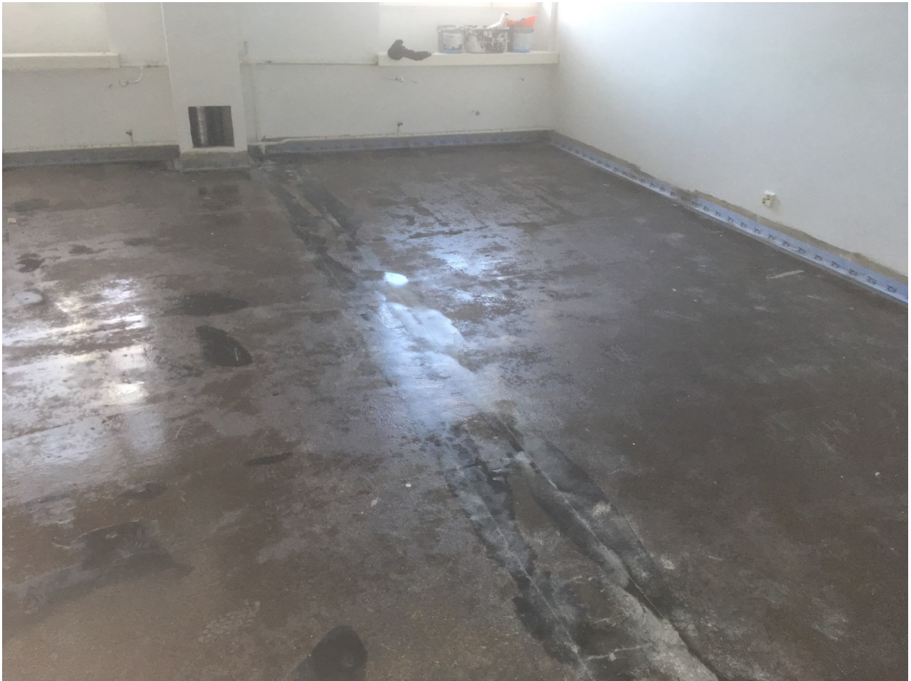
Kuva 15. 3 krs betonilattiaan on levitetty epoksi. Epoksin käytöllä varmistetaan ettei betoniin mahdollisesti jääneet pienetkään VOC -yhdistejäämät pääse huonetilaan. Reunojen tiivistenaumat antavat lisävarmistuksen tiiveydelle.
