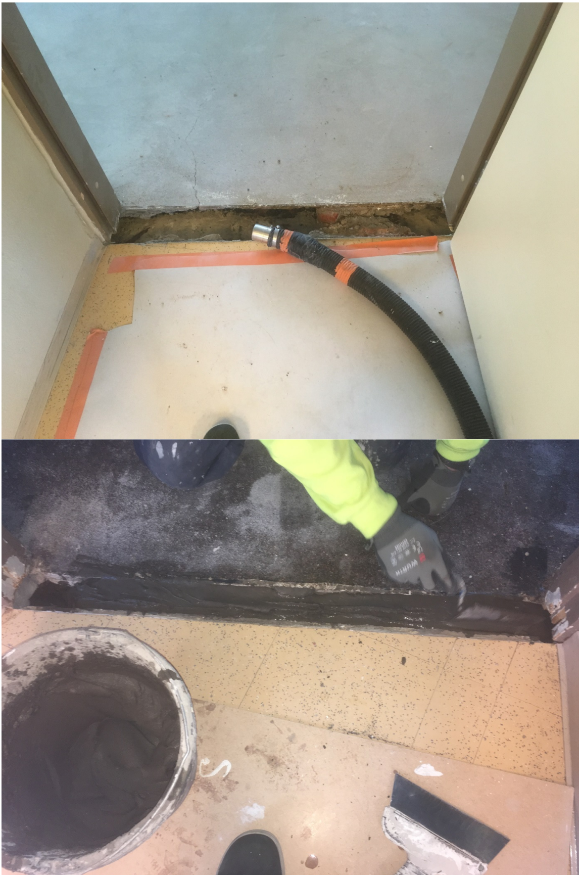
Kuva 16. 3. kerroksen ovien lattiaan upotetut puukynnykset poistettiin ja täytettiin puhtaan sisäilman kannalta paremmalla ratkaisulla, betonimassalla.
