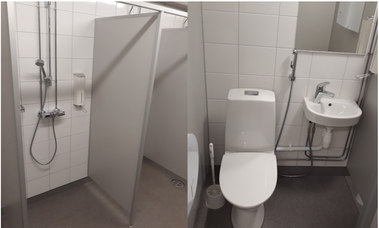
Kuva 22. Valmiita suihku- ja wc-tiloja
