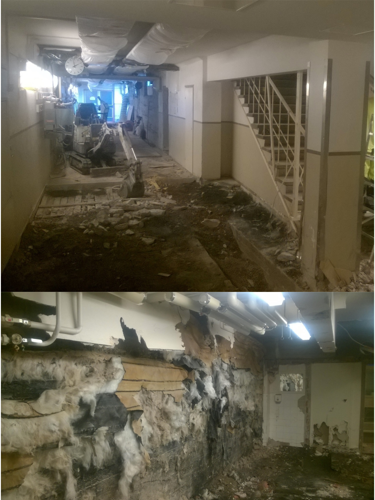
Kuva 2. Maanvaraisten alapohjien ja kellarinseinien ns raskas korjaus. Vanhat rakenteet vaurioherkkine eristeineen puretaan pois ja korjataan kosteusteknisesti toimiviksi.
