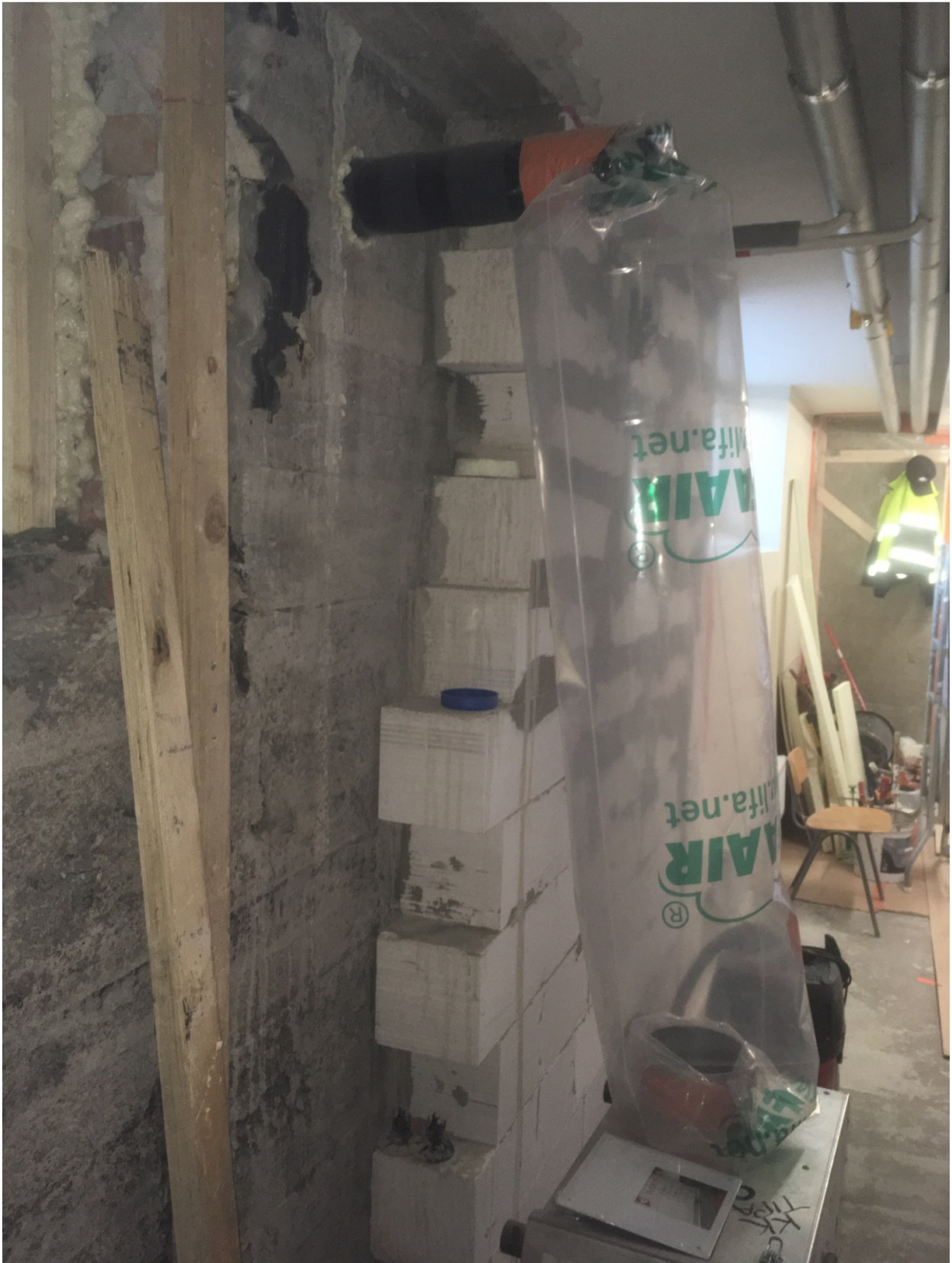
Kuva 5. Kellarikerroksen ulkoseinän uutta rakennetta. Betonisen ulkoseinän sisäpintaan on kiinnitetty kevytbetoni harkkomuuraus. Harkko tasoitetaan ja maalataan vesihöyryä läpäisevällä silikaattimaalilla. Pölyävät työvaiheet tehdään alipaineistetussa tilassa.
