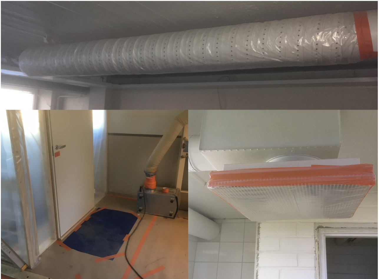
Kuva 18. Työmaalla kiinnitettiin erityistä huomiota pölynhallintaan ja mm ilmastointipääte-elimien suojaukseen.
