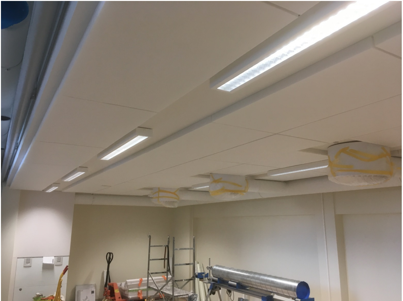
Kuva 17. Luokkatilan katon akustoinnissa on käytetty Ewona äänenvaimennuslevyjä joille on myönnetty Allergia- ja astmaliiton allergiatunnus sekä M1-päästöluokitus. Näin varmistetaan ettei akustointimateriaalit aiheuta huonetilaan haitallista kuituongelmaa.
