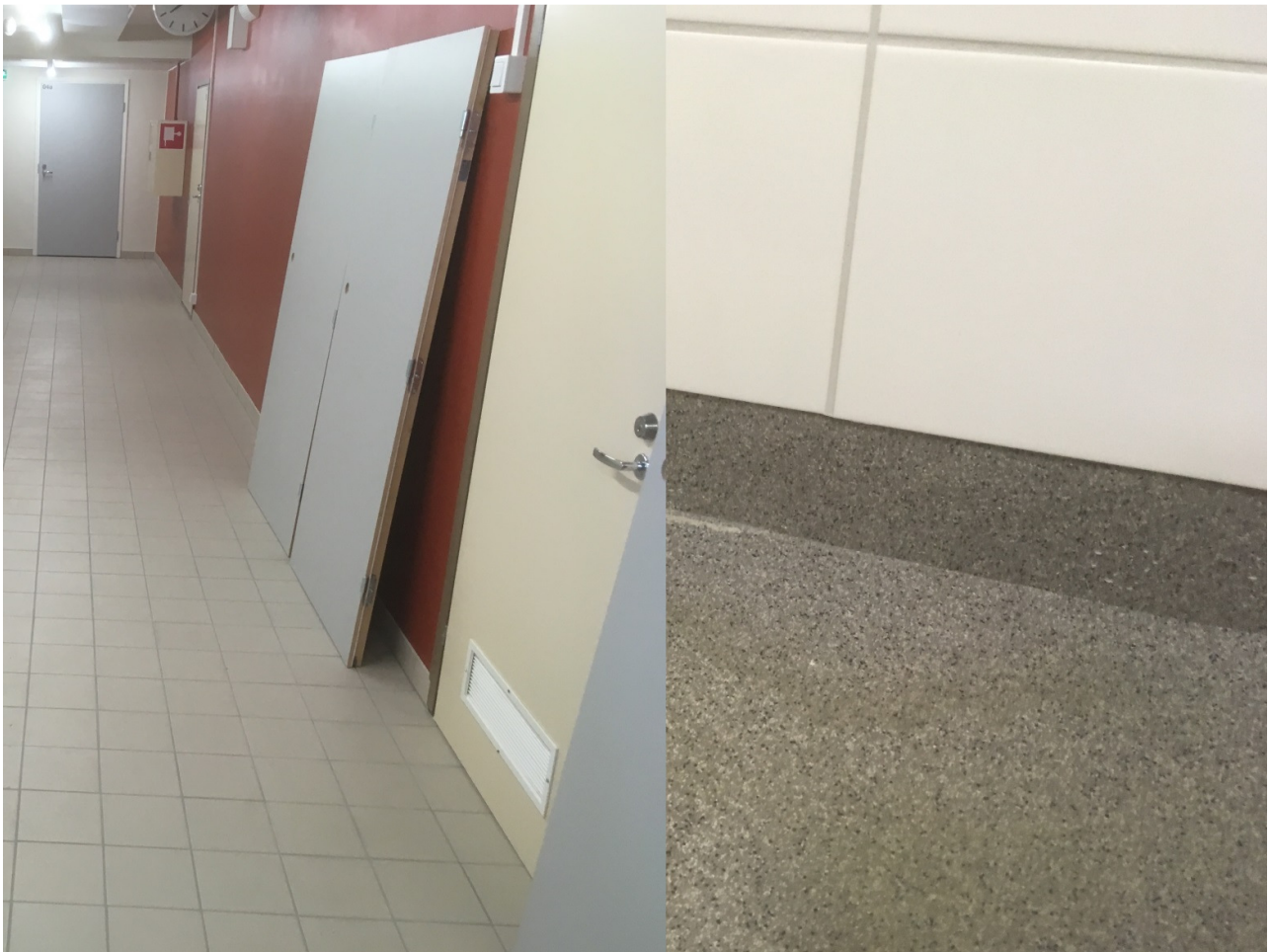
Kuva 12. Kellarikerroksen valmiita lattiapintoja (vasemmalla keraaminen laatta, oikealla akryylibetoni). Hyvä sisäilmama on pyritty varmistamaan myös turvallisilla materiaalivalinnoilla. Kellarikerroksessa ei ole käytetty esim muovimattoja ollenkaan.
