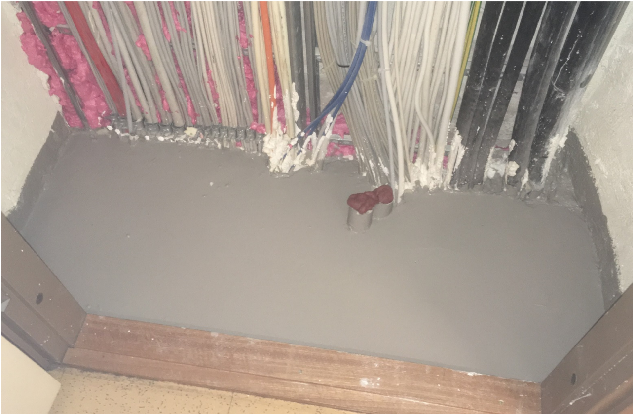
Kuva 19. Kaapeliläpivientien ja muiden tekniikkahormien tiivistykset tarkastettiin huolellisesti. Näin estetään sisäilman kannalta haitalliset ilmanliikkeet hormien kautta käytössä oleviin tiloihin, lisäksi parannetaan paloturvallisuutta.
