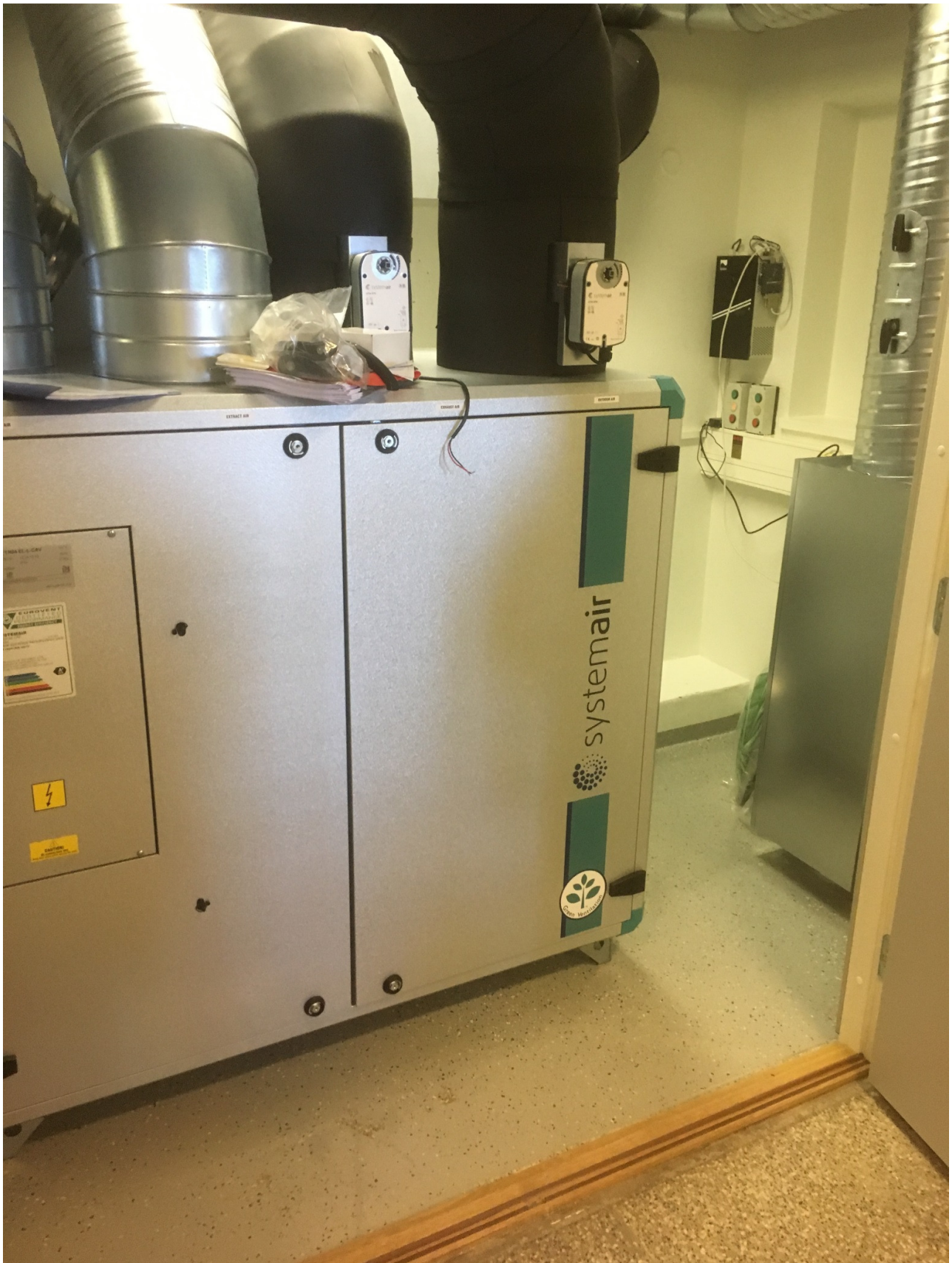
Kuva 11. Kellarikerroksen wc-tilojen ilmastointia palvelemaan rakennettiin uusi iv-konehuone rakennuksen 1. kerrokseen entisen kiinteistöhoitajan tilan paikalle.
