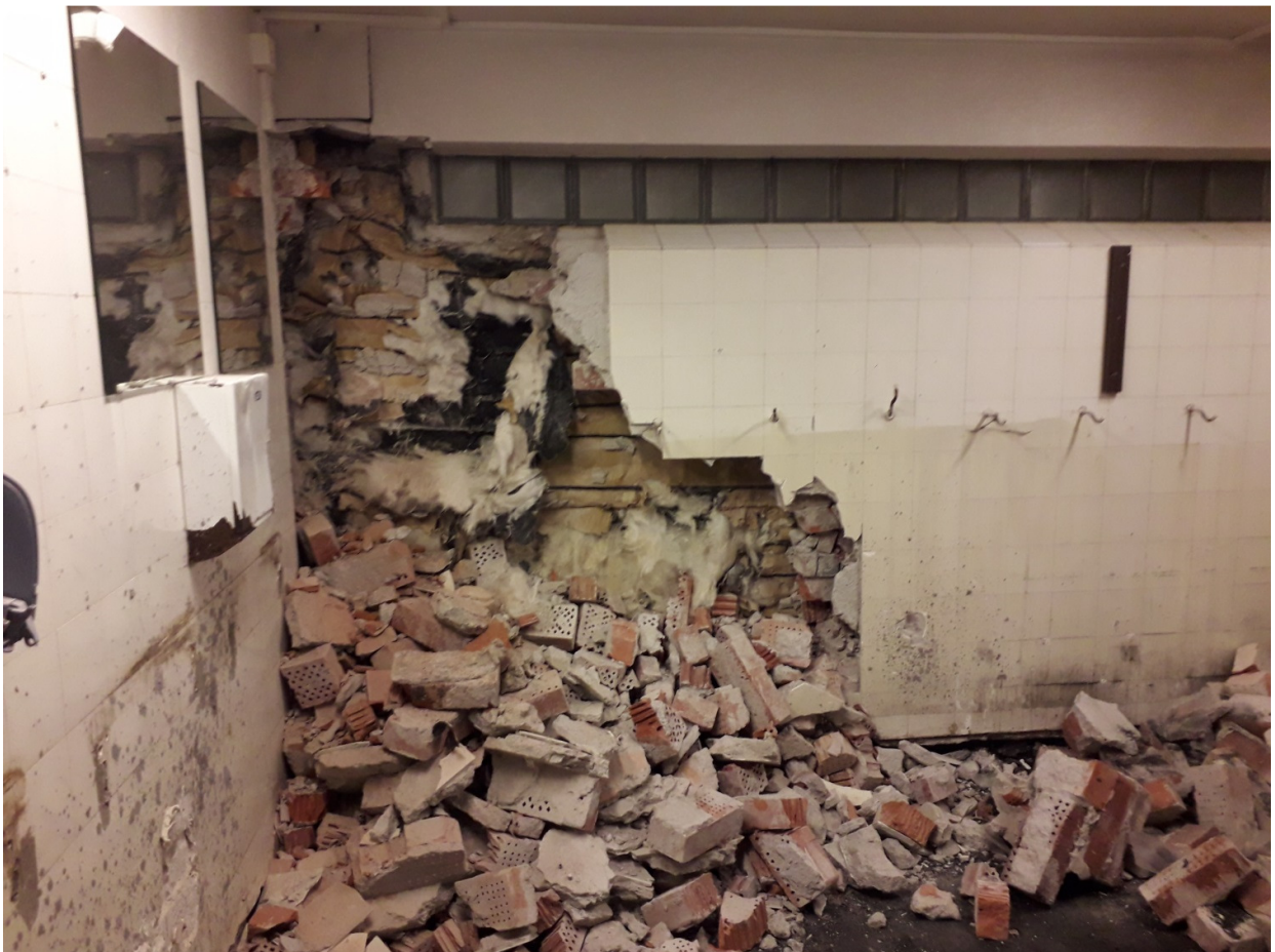
Kuva 4. Kellarikerroksen ulkoseinän riskirakenteiden purkutyötä.
