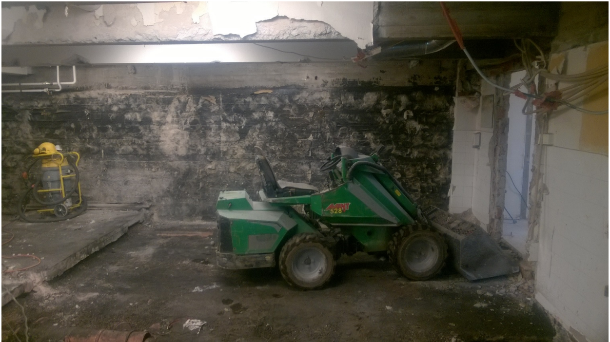
Kuva 3. Kellarikerroksen purkutyöt olivat perusteelliset. Purku-urakoitsijana toimi Kymen Asbestipurku ja Romutus Oy. Purkujäte kuljetettiin pois työmaalta kuvassa näkyvällä koneella.
