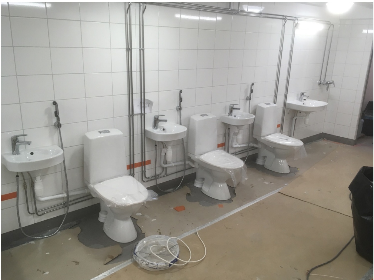
Kuva 10. Valmista pintaa. Putkimies on asentanut wc-kalusteet. Uudet wc-jakoseinät puuttuvat vielä.
