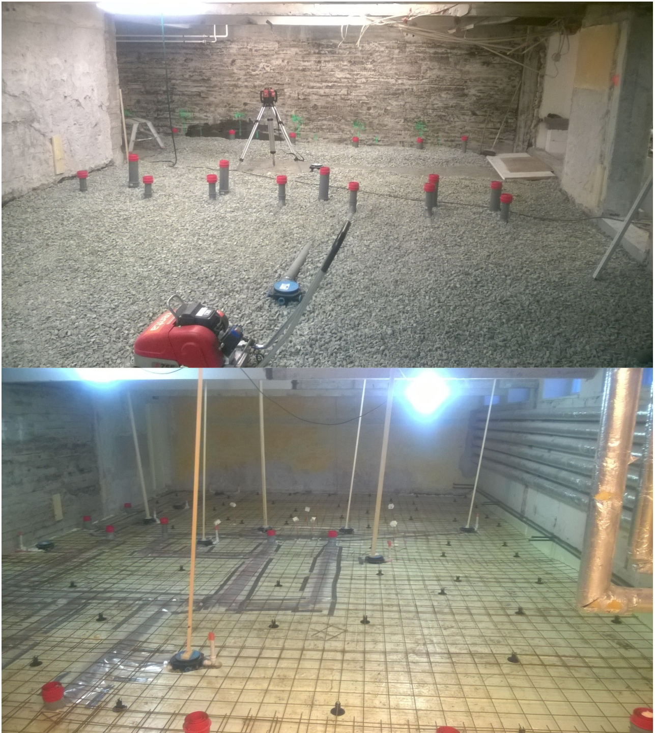
Kuva 8. Kellarikerroksen lattia näytti tältä ennen uuden betonilaatan valua. Lattian lämpöeristeenä käytettiin XPS-eristettä.
