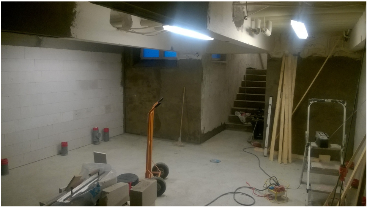
Kuva 9. Kellarikerros, purkutyöt on tehty ja tilat siivottu. Uusi maanvarainen laatta on valettu. Kohteessa panostettiin työn aikaiseen siivoukseen.
