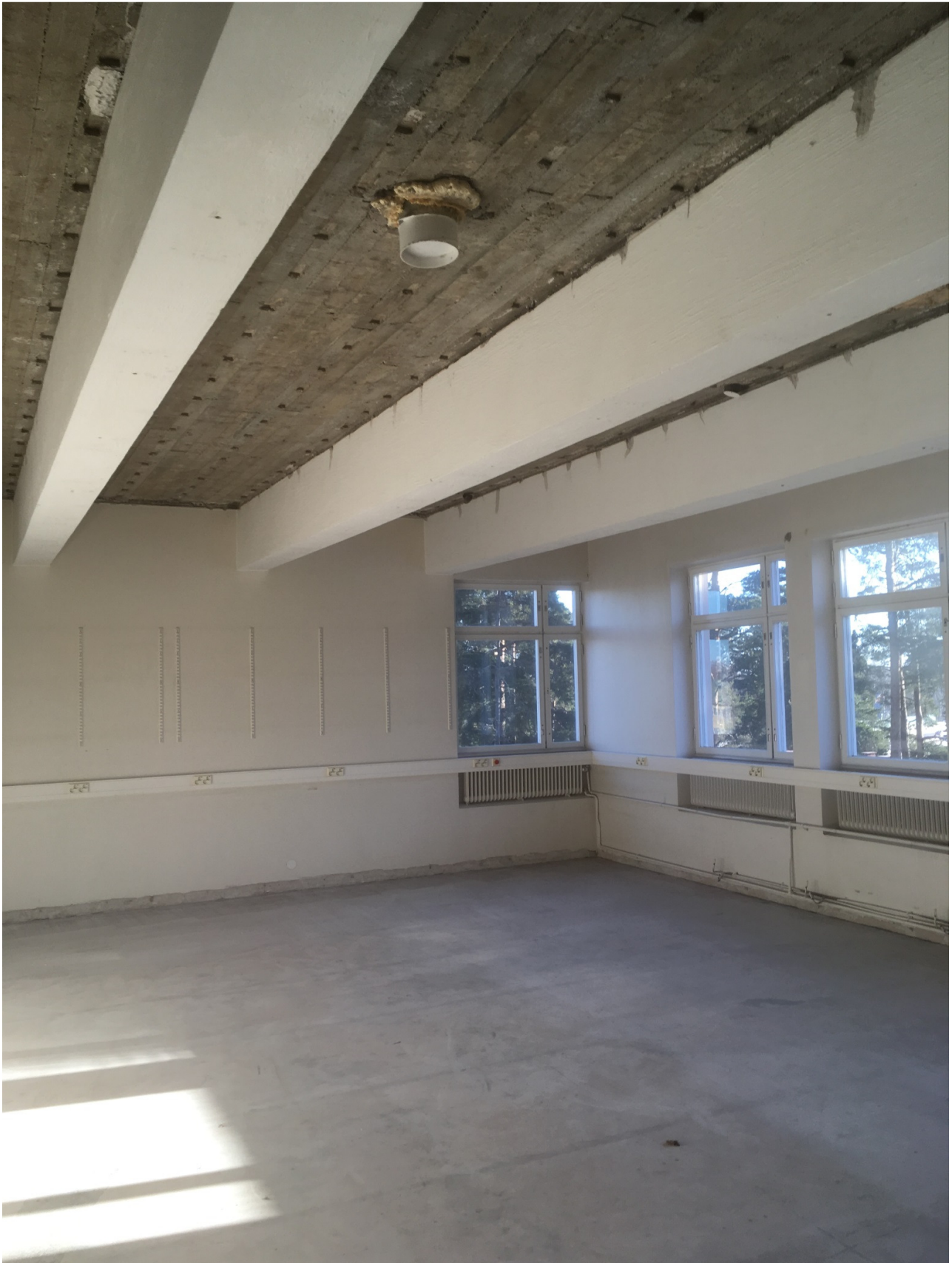
Kuva 13. 3 krs luokkatila purkutöiden jälkeen. Lattiapinnoitteet ja katto purettu betonipinnalle.
