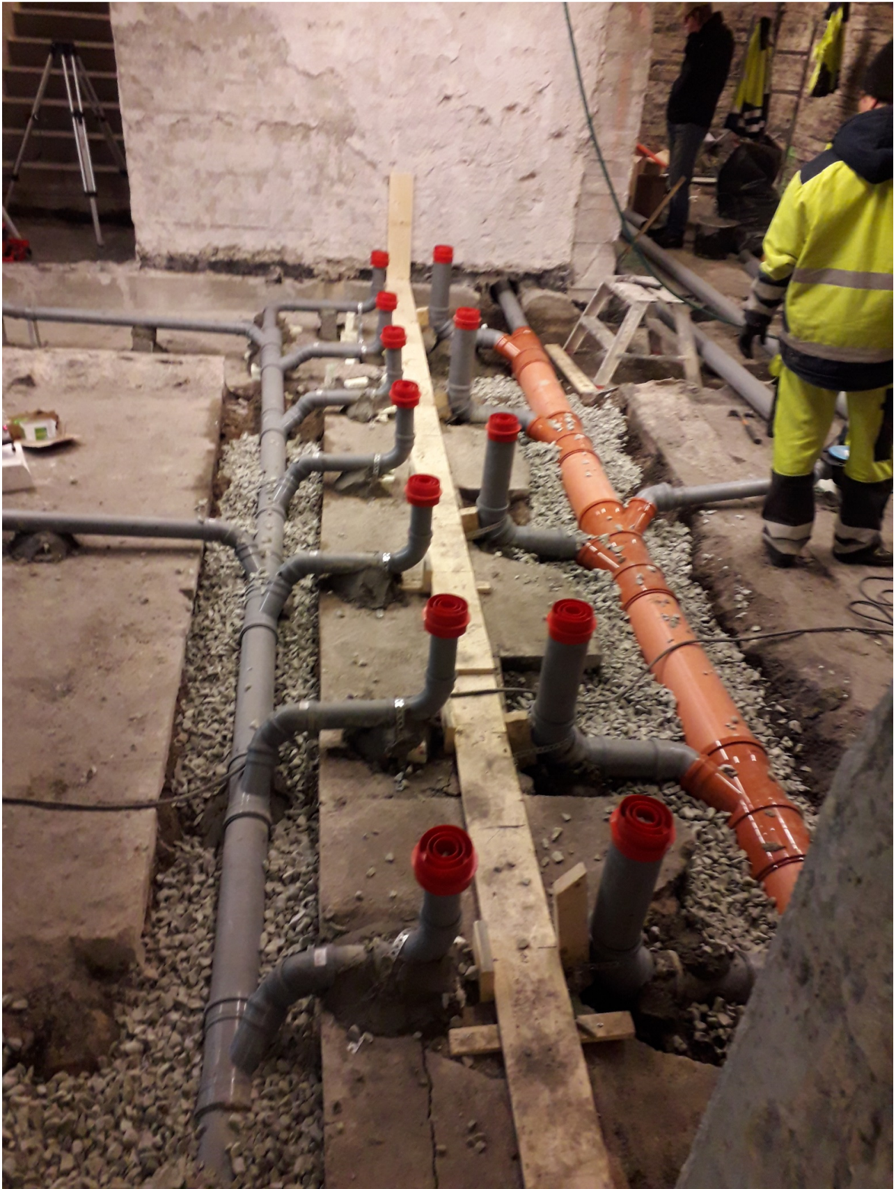
Kuva 7. Pohjakerroksen wc- ja pukutilat kokivat täydellisen muodonmuutoksen. Tässä asennetaan uusia viemäreitä.
