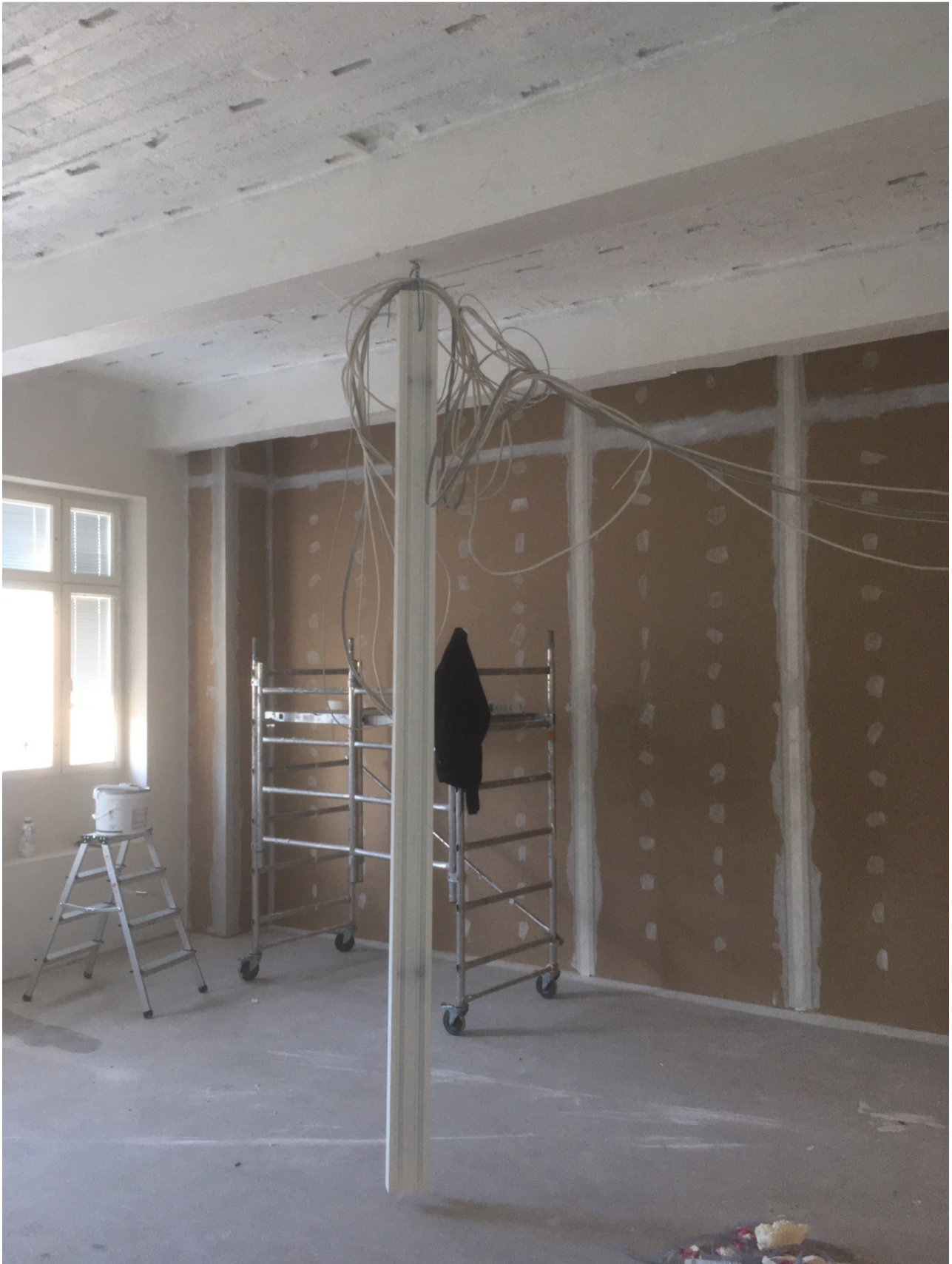
Kuva 14. 3 krs yläpohjarakenne on tiivistetty alapinnastaan Blowerproof ilmatiiviillä pinnoitteella. Näin estetään ilman kulku yläpohjan eristetilasta huoneilmaan.
