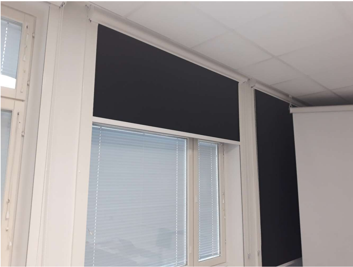
Kuva 7. Ikkunoiden ja seinärakenteen liitokset tiivistettiin Blowerproof menetelmällä. Pimennysverhot uusittiin.
