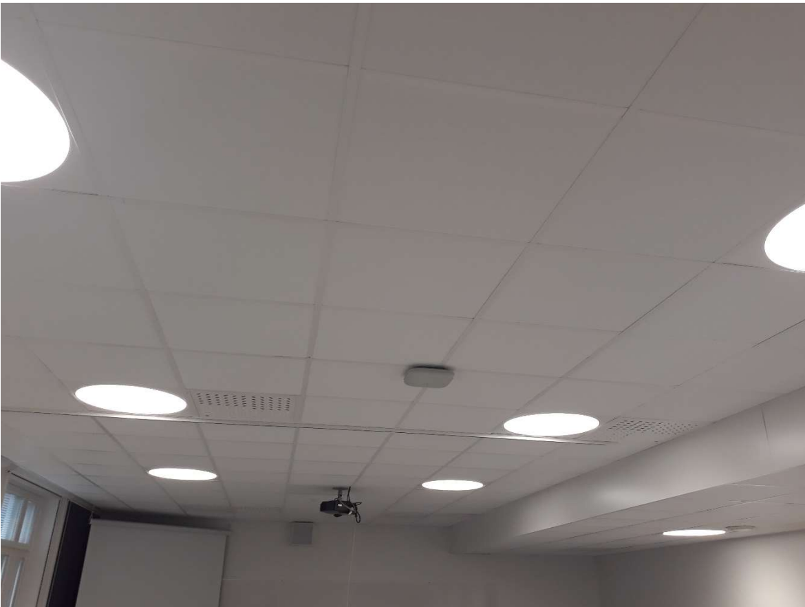
Kuva 6. Valmis alakatto. Valaisimet ja ilmastoinnin päätelaitteet uusittu.
