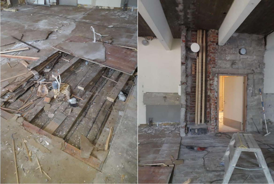
Kuva 1. Välipohjalaatan päälle koolattu puurakenteinen lattia purettiin kokonaan pois betonille asti.
