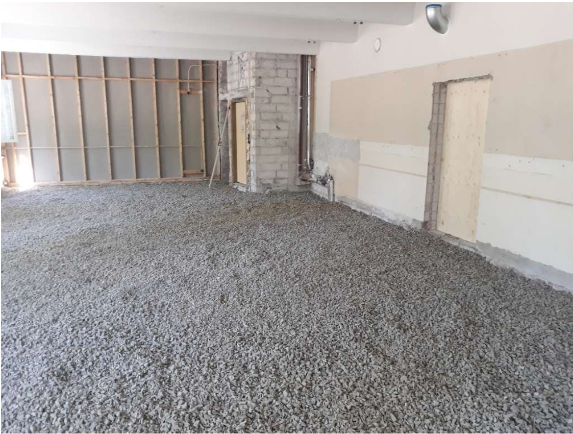
Kuva 3. Täyttö puretun puurakenteisen lattia tilalle, vaahtolasimursketta. Uusi lattiarakenne vaahtolasimurskeen päälle: XPS-eristelevy, lattialastulevy uivana rakenteena sekä muovimatto.
