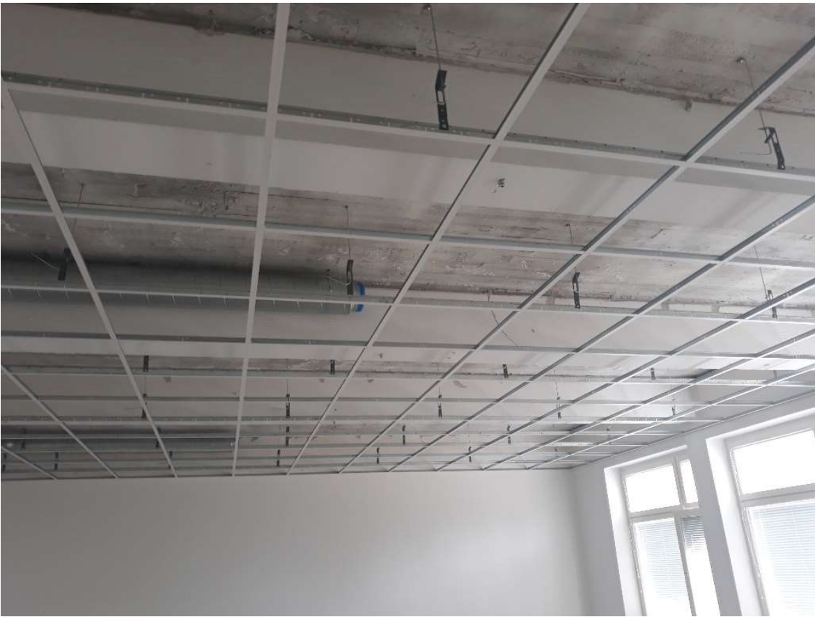
Kuva 5. Luokkien uudet alakatot T-listajärjestelmällä. Alakaton yläpuoliset pinnat käsitelty pölynsidonta-aineella.
