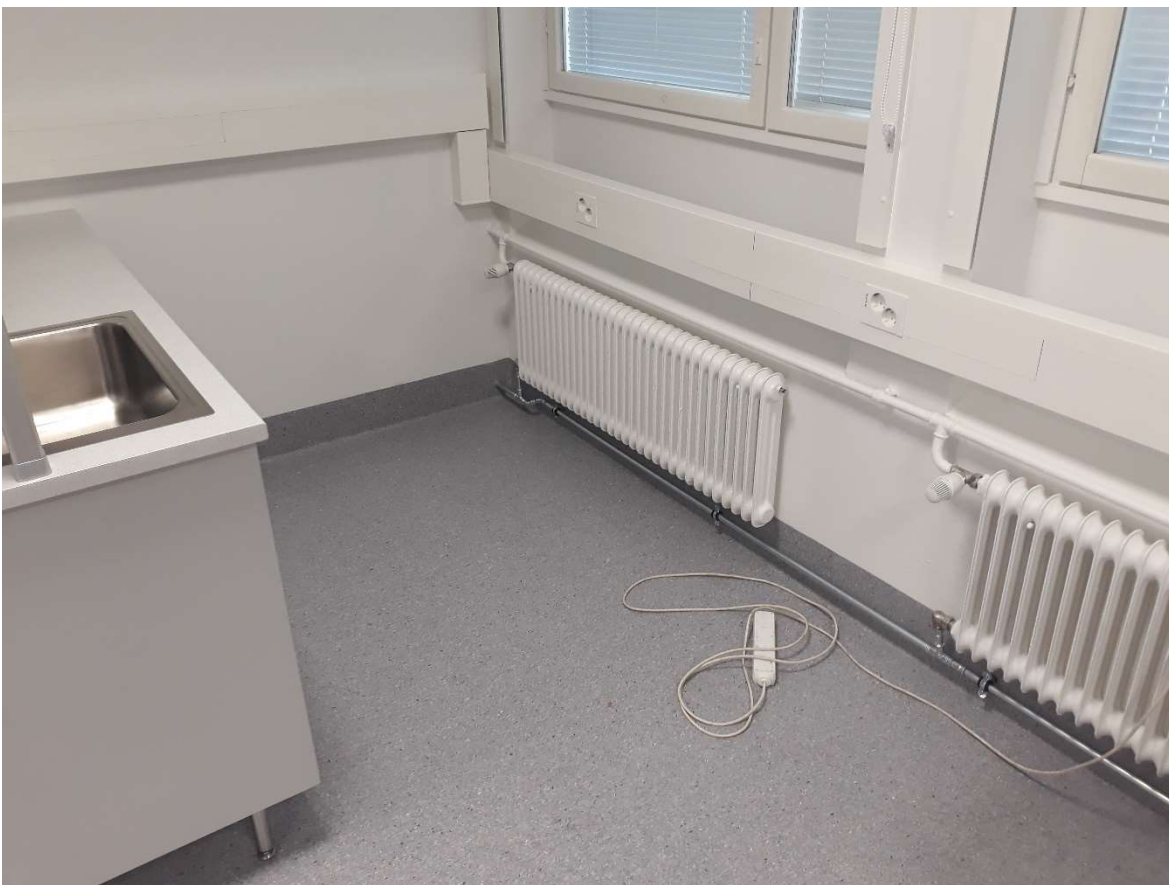
Kuva 4. Muovimatot asennettiin nostoilla seinille. Lämpöjohdot ja kalusteet uusittu.
