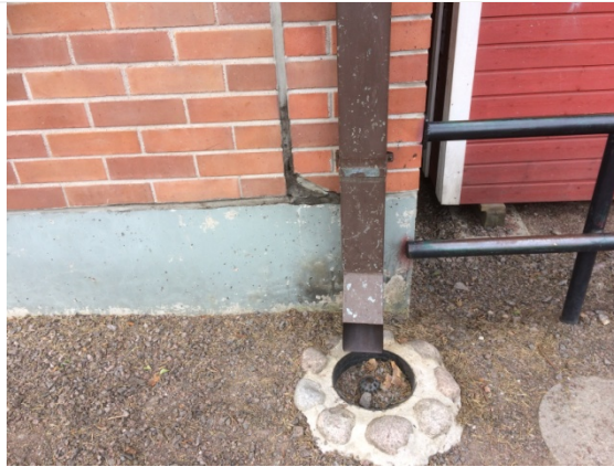
Kuva 17. Elementtisauma ylärinteen puolella
