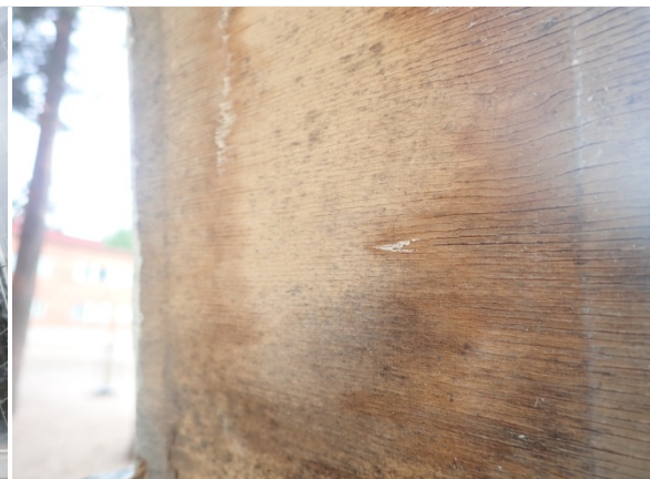
Kuva 16. Ikkunanvälien levytykset tummuneita sisäpinnaltaan
