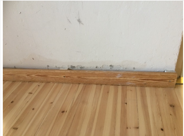
Kuva 12. Pinnoitevaurio seinän alareunassa.
