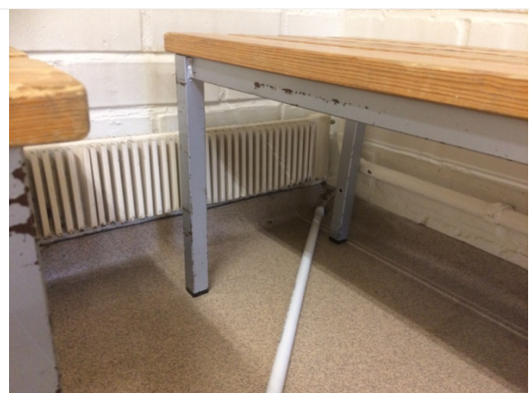
Kuva 24. Merkkiainemittauksessa ilmavuotoa mattonoston alta, seinän ja lattian liitoksesta
