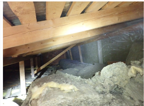
Kuva 28. Matalan osan yläpohja
