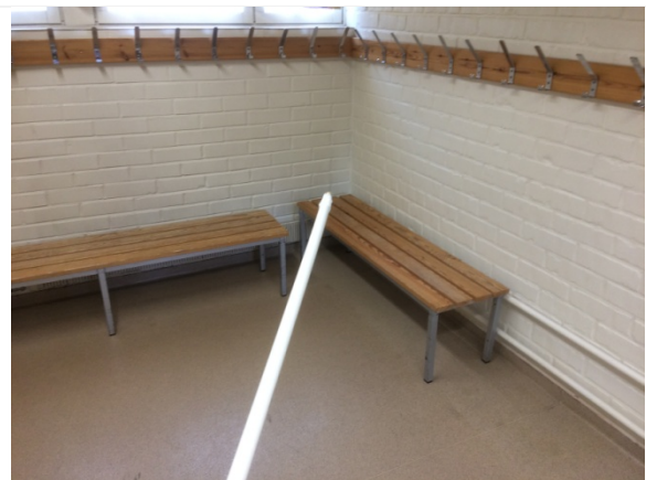
Kuva 22. Merkkiainemittauksessa ilmavuotoa muuratun seinärakenteen saumoissa
