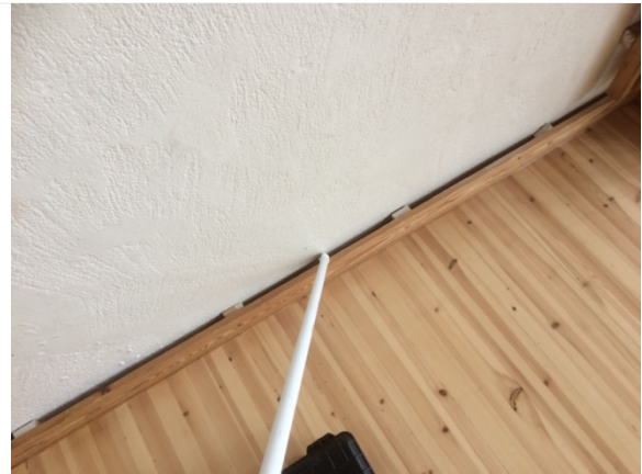
Kuva 20. Merkkiainemittauksessa ilmavuotoa lattian ja seinän liitoksesta
