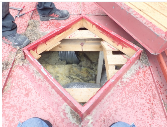
Kuva 27. Matalan osan yläpohjan käyntiluukku
