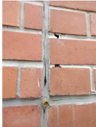
Kuva 18. Elementtisauma epätiivis
