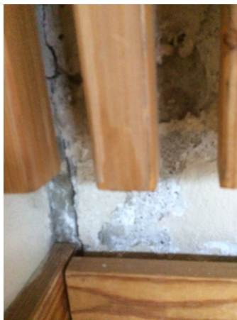
Kuva 13. Pinnoitevaurio pilarin vieressä
