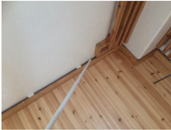
Kuva 19. Merkkiainemittauksessa ilmavuotoa lattian ja seinän liitoksesta
