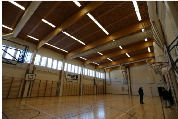
Kuva 29. Halliosan yläpohjarakenne
