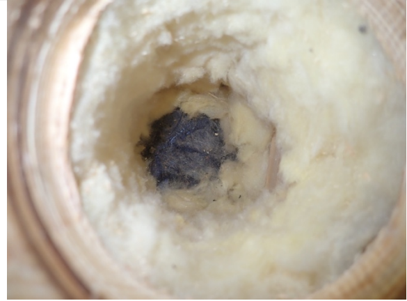
Kuva 5. Maanvarainen laatta on pääosin bitumoitu. Lämmöneristys on betonilaatan päällä.
