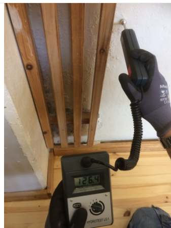
Kuva 14. Ulkoseinärakenteen sisäkuoren pintakosteusmittauksessa betonirakenteen kosteus koholla (Gann lukema 126)
