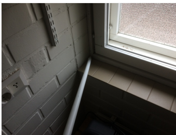
Kuva 23. Merkkiainemittauksessa ilmavuotoa ikkunaliitoksessa
