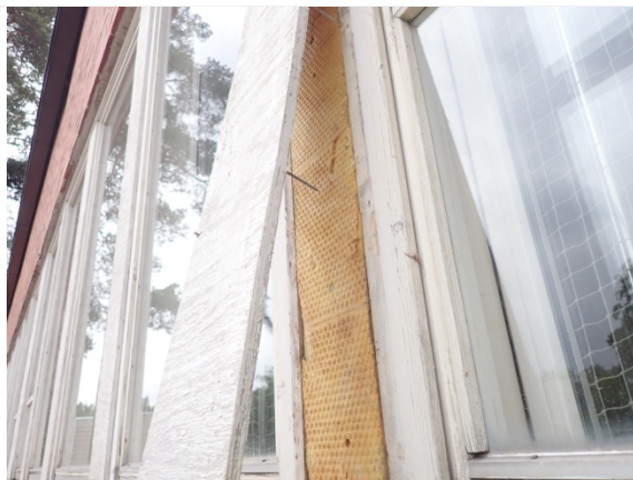
Kuva 15. Ikkunan väli eristetty mineraalivillalla
