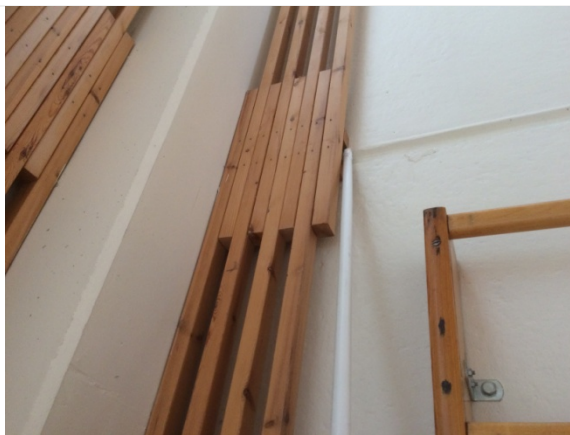
Kuva 21. Merkkiainemittauksessa ilmavuotoa elementin saumassa
