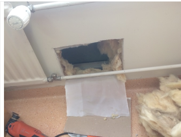
Kuva 7. Ulkoseinärakenteen avaus opetusvä- linevarastossa 262
