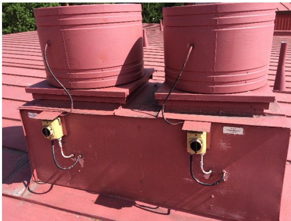
Kuva 18. Keittiön ja ruokalan poistoilmapuhaltimet PF3.1 ja PF4.1.
