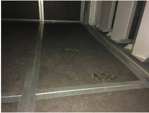
Kuva 10. Villapintaa tuloilmakoneessa. Repeämät käsitelty.
