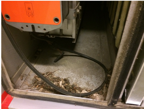
Kuva 14. Roskia koneessa TK2 ennen suodatinta.
