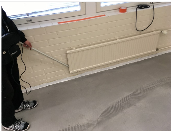
Kuva 5. Patterin kannakkeen ja seinän liitoksesta löytnyt ilmavuoto
