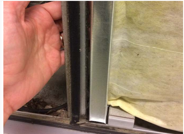
Kuva 15. Suodatinkehikkeen otsapinta ei painu tiiviisti suodatinaukon reunoja vasten, TK2.
