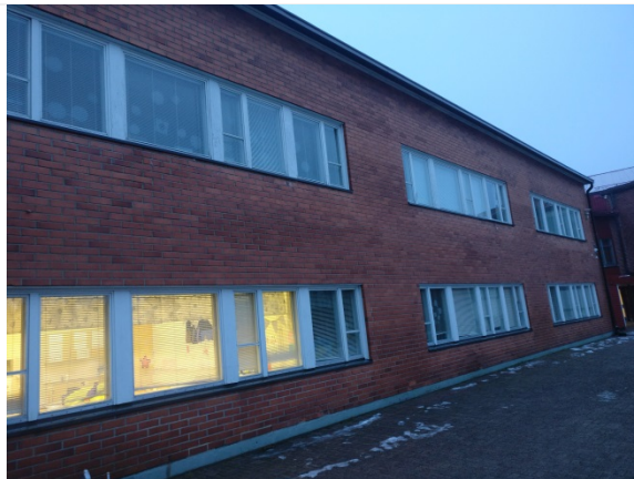
Kuva 1. Julkisivua yleisesti, kuvattuna tilan 181 kohdalta sisäpihalla.
