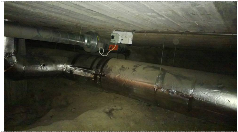
Kuva 25. Alapohjan poistoilmapuhallin PF10.
