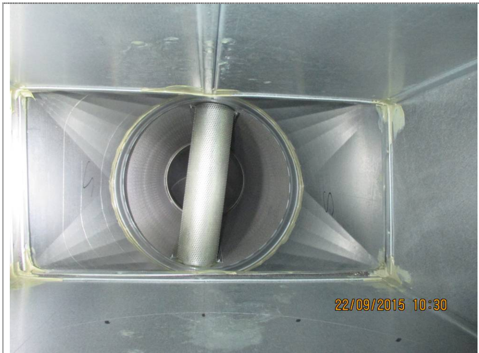
Kuva 27. Reikäpellillä päällystettyä mineraalivillaa kellarikerroksen tuloilmakanavan äv-osassa.
