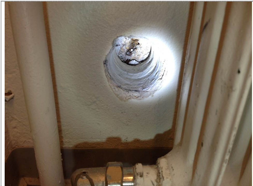
Kuva 7. Auditorion maanvastaisen seinän rakenneavaus. Betonikuoren takana lämmöneristeenä korkki.
