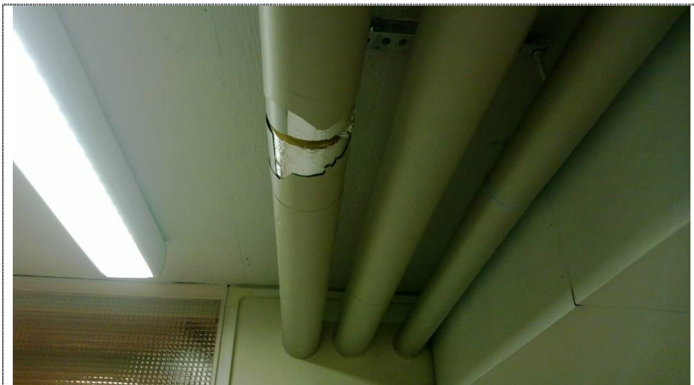
Kuva 16. Putkieristeet ovat muovikuorella päällystettyä mineraalivillaa.
