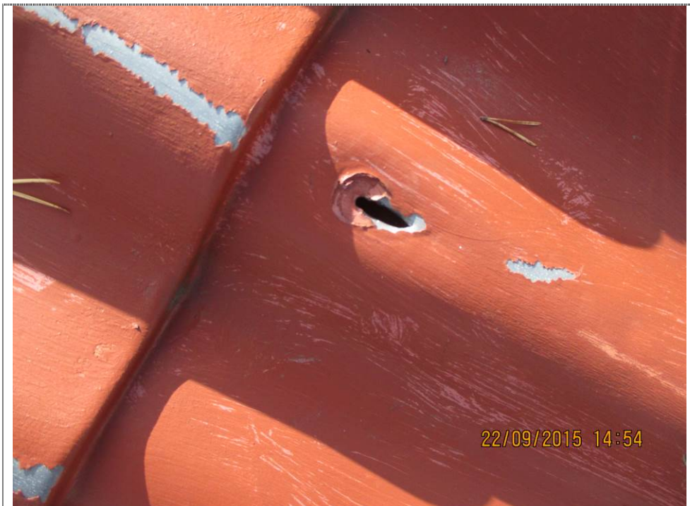
Kuva 14. Vesikatteessa paikoittain reikiä.
