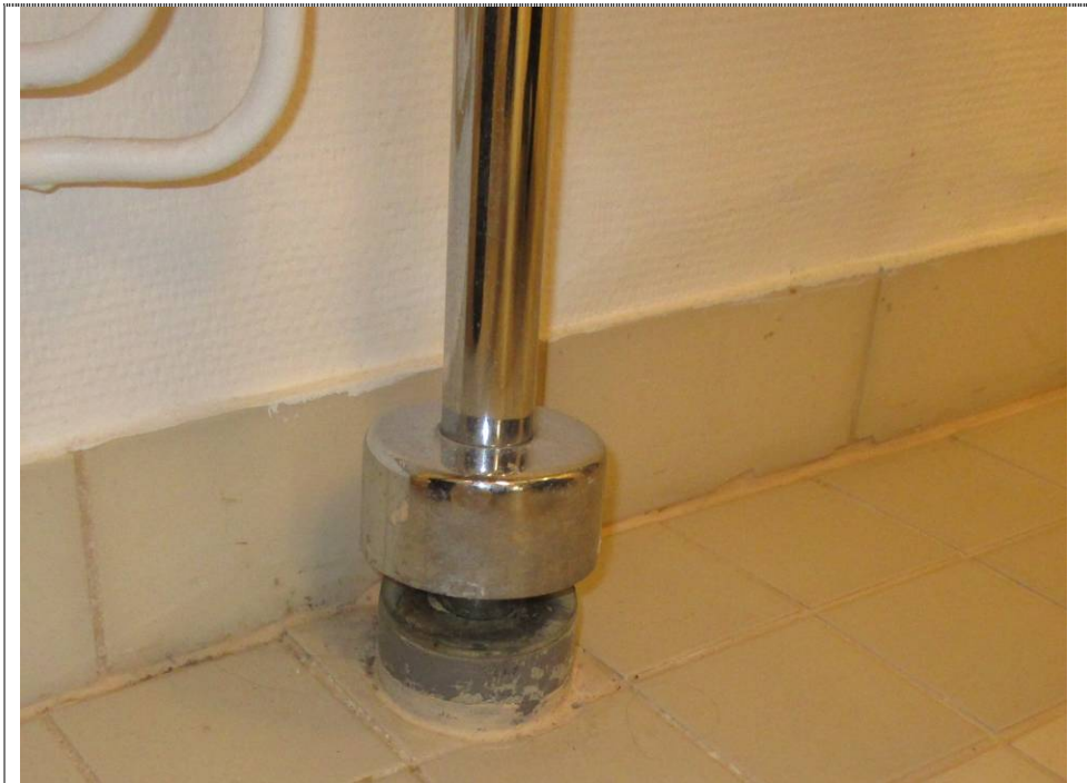
Kuva 19. Siisti viemärin tiivistys kellarikerroksen uusissa viemäreissä.
