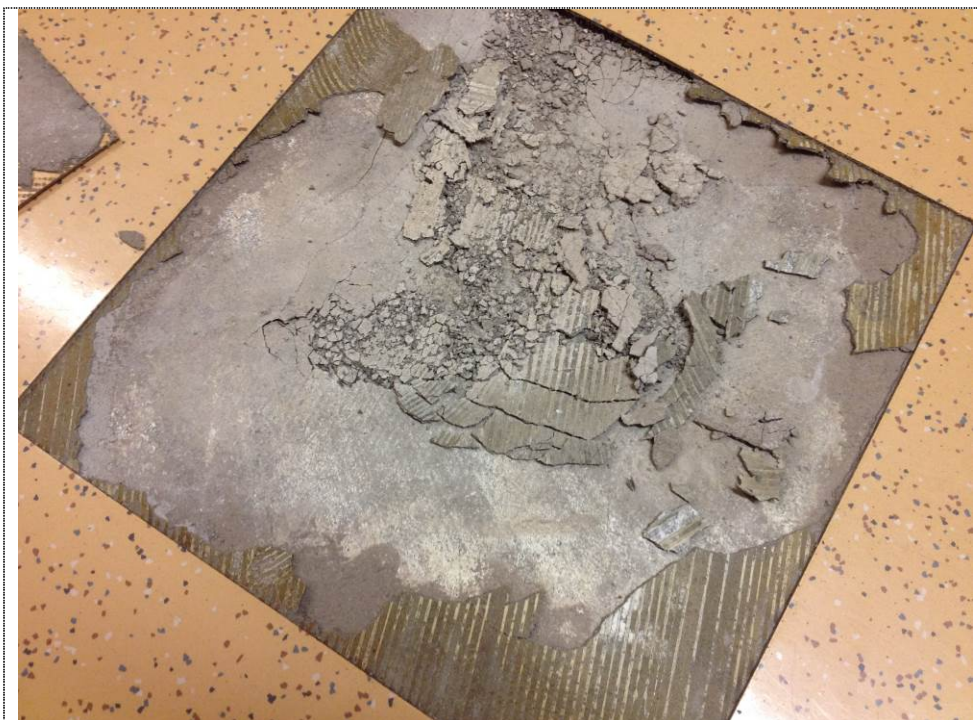
Kuva 2. Kellarikäytävä 028, tasoitteet irronneet vinyylilaatan alta.
