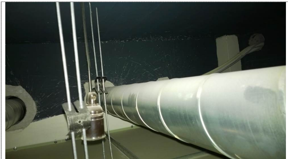
Kuva 30. Tunkkainen haju ja jonkin verran rakennusaikaista pölyä alakaton yläpuolisessa tilassa (kuraattorin huone)
