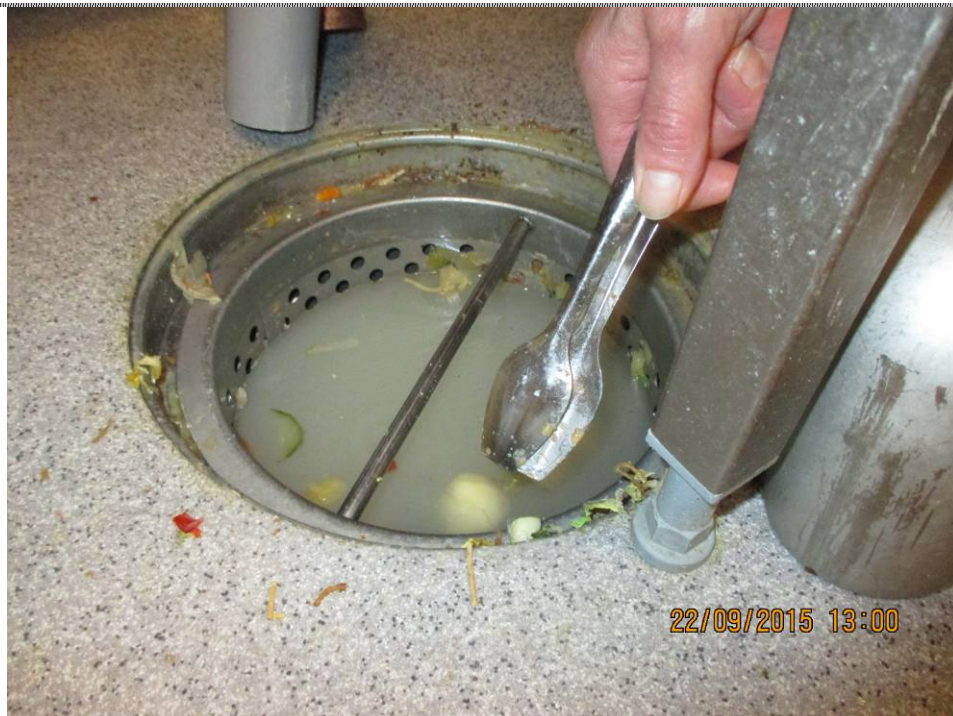
Kuva 22. Ruokalan keittiön esihuuhtelun lattiakaivo tukkeutuu ruuanjätteistä.
