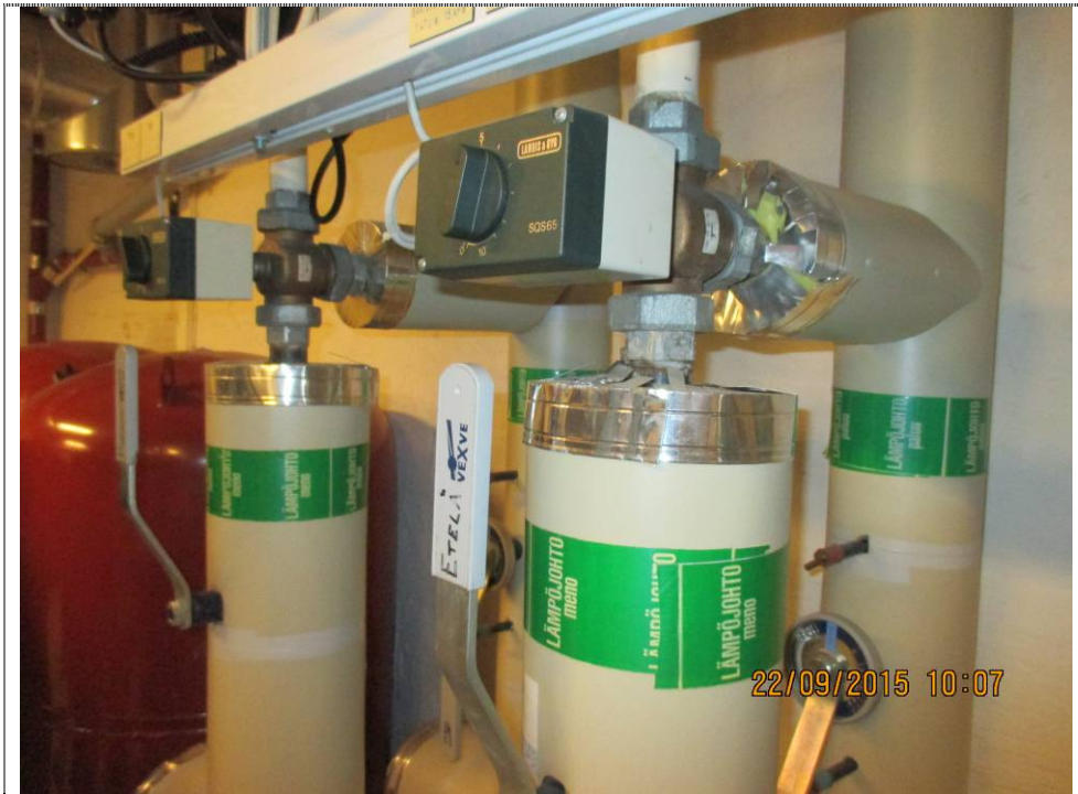
Kuva 15. Lämmityspiirien säätölaitteet ovat vuodelta 1996.
