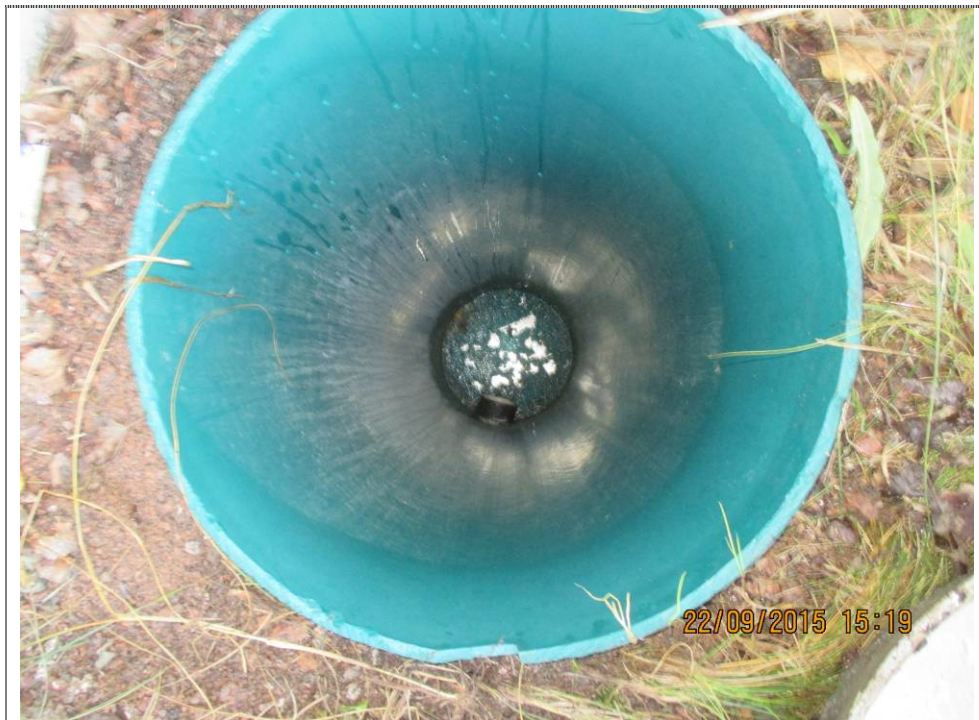
Kuva 23. Uusittu salaojakaivo.
