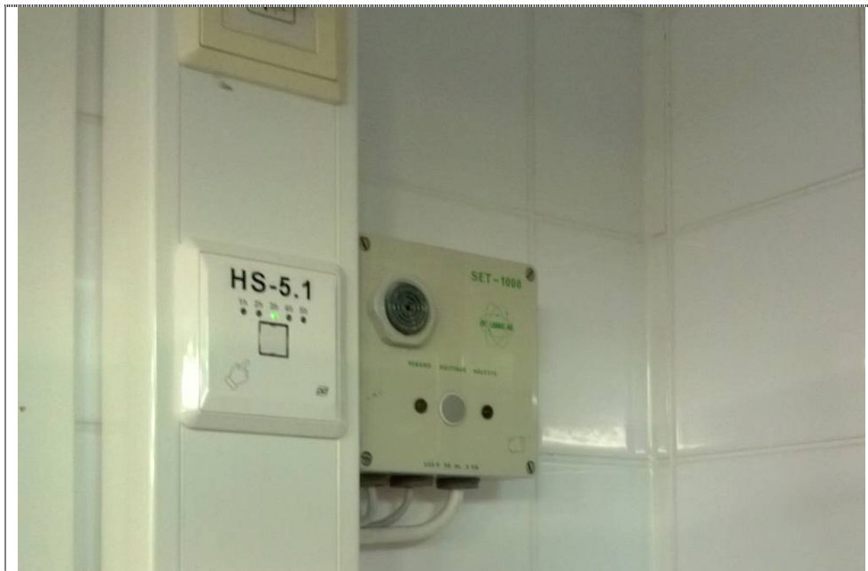
Kuva 29. Ilmanvaihdon aikakytkin ja rasvanerottimen rajapintahälytys keittiön seinällä. Aikakytkin ei toiminnassa, ilmanvaihto 1/1-nopeudella 24/7
