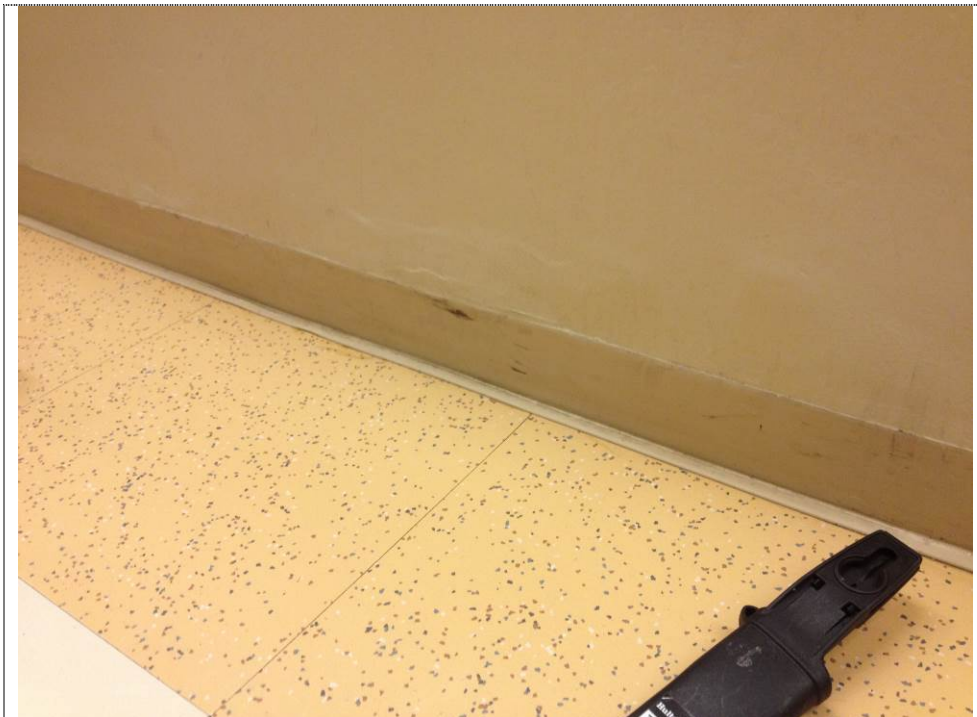
Kuva 4. Kellarikerroksen väliseinien alaosissa viitteitä kosteuden noususta.
