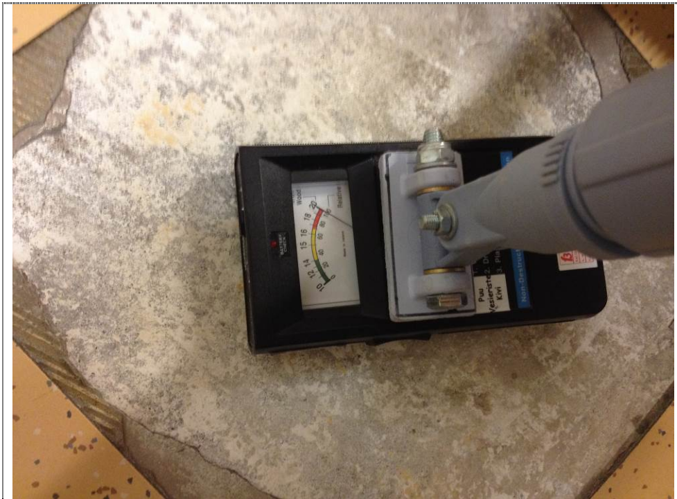
Kuva 3. Kellarikäytävä 028, pintakosteudenosoittimella betonilaatan pinta kostea
