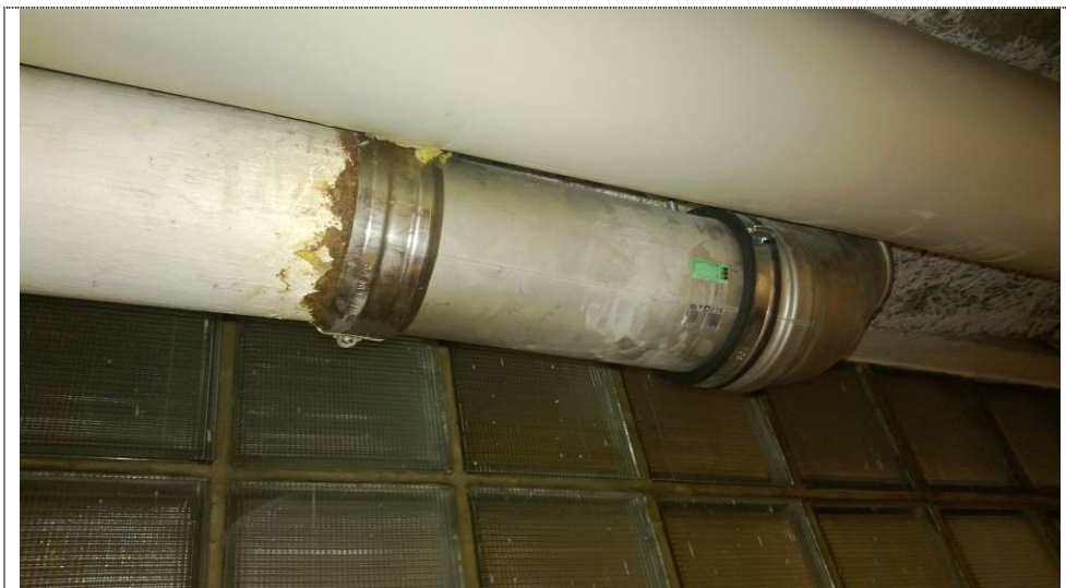
Kuva 20. Uuden ja vanhan viemärin liitos.
