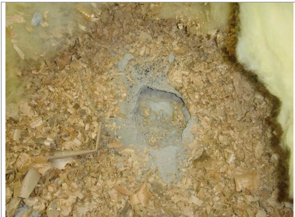
Kuva 12. Yläpohjan rakenneavaus: mineraalivillaeristeen alla paikoittain purua.
