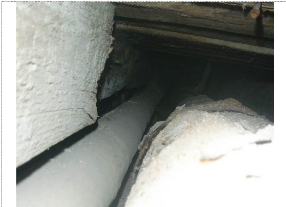
Kuva 6. Varastosta 037.2 alapohjarakenteeseen tehdystä rakenneavauksesta havaittiin putkikanaalissa vanhoja muottilautoja sekä mahdollisesti asbestieristettyjä lämpöputkia.
