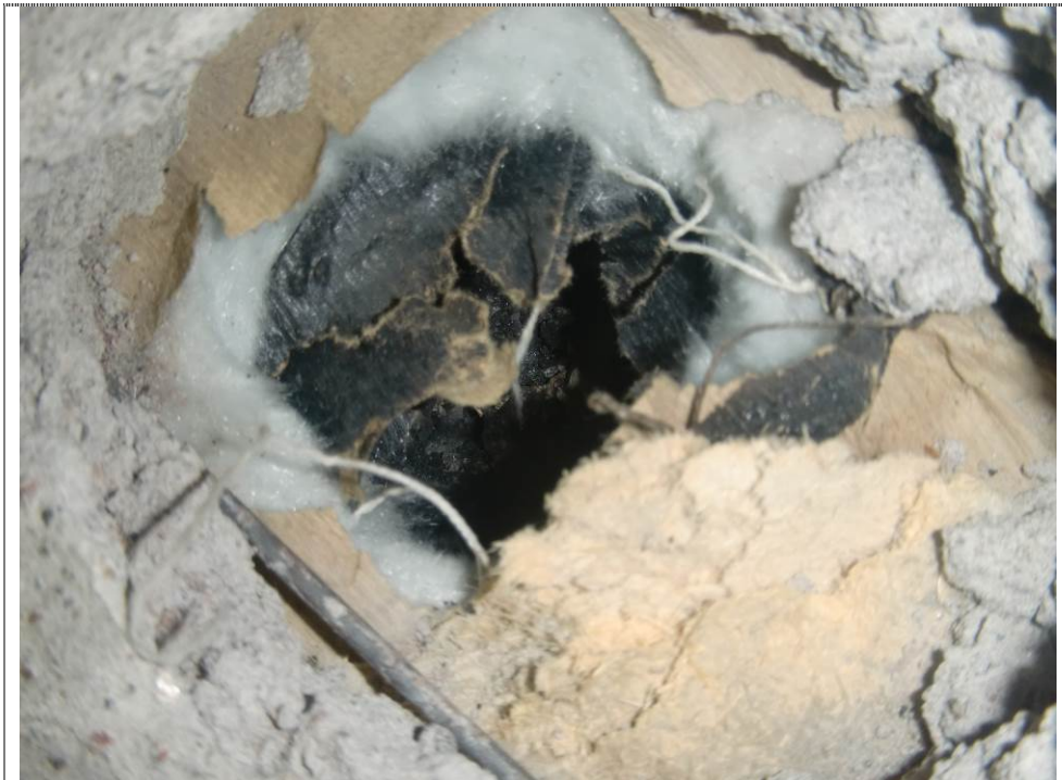
Kuva 13. Yläpohjan rakenneavaus: Betonisen palopermannon alla kuitulevy, lasivillaa ja koksinkuonaa.
