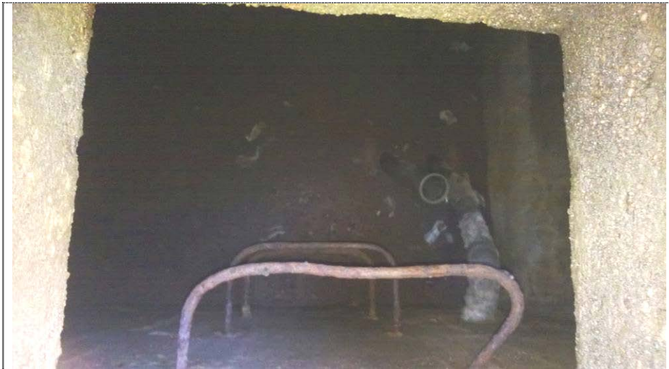
Kuva 21. Vanha hajotuskaivo ulkopihan puolella.
