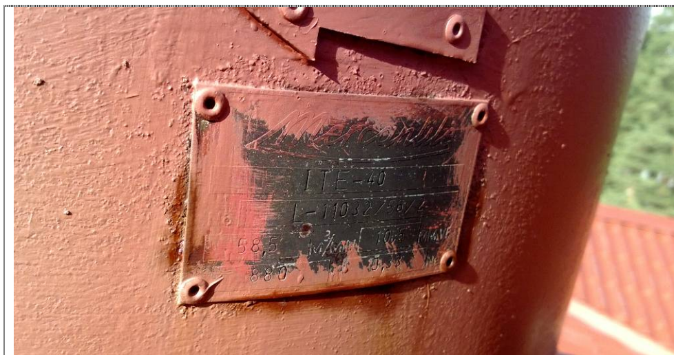
Kuva 24. Vanha huippumuri vesikatolla (konekyltti).
