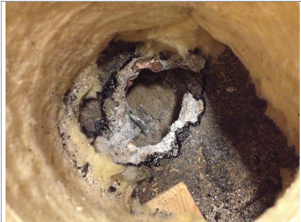
Kuva 5. Kellarikäytävän 048 puu-koolatun lattian rakenneavaus. betonilaatan päällä vedeneristeenä bitumi ja lämmöneristeenä mineraalivilla.
