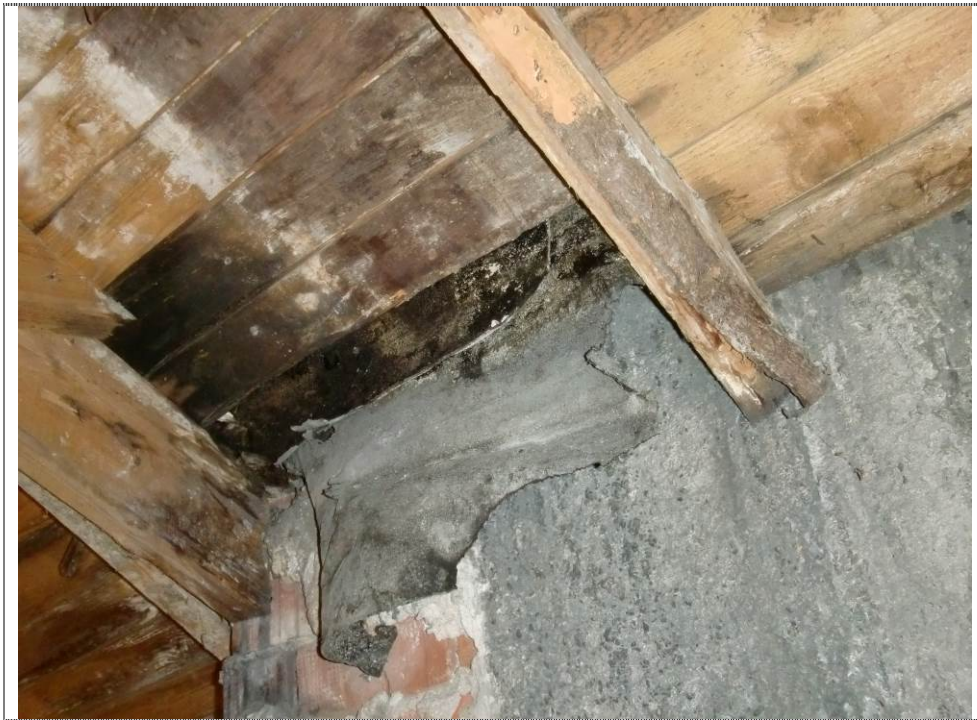
Kuva 11. Vesikaton aluslaudoitus paikoittain huonossa kunnossa
