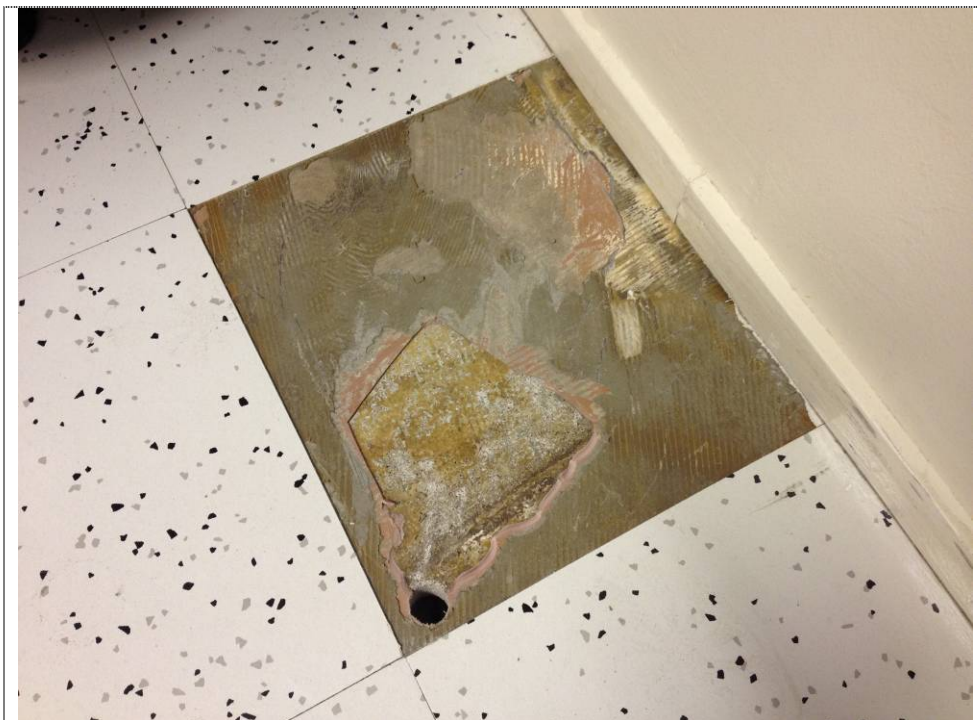
Kuva 10. Rehtorin huoneen 220 lattiarakenteessa kahta eri pinnoitetta päällekkäin.
