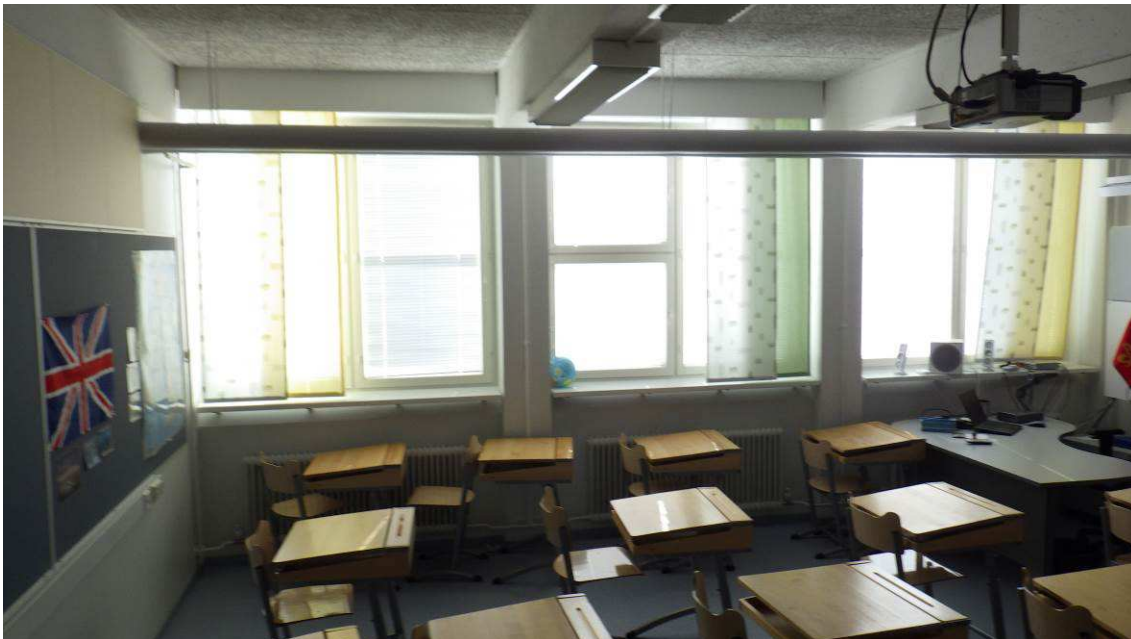
Kuva 2. Luokan 128 keskimmäisen ikkunan alapuolelle tehtiin avaus AV1.
