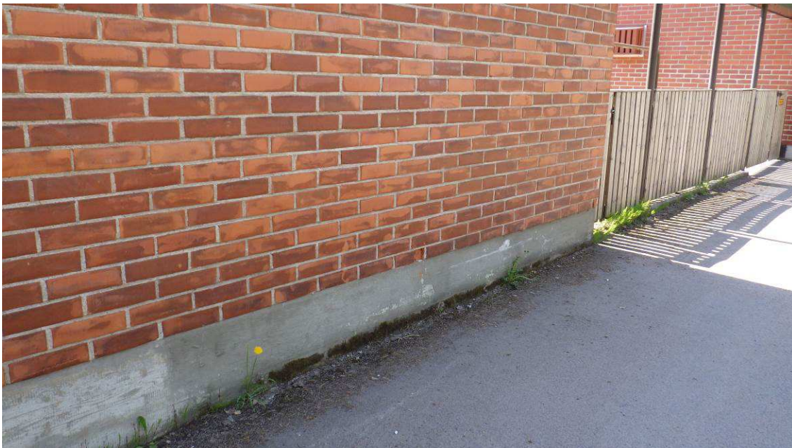
Kuva 8. Terveystieteiden rakennuksen ulkoseinässä ei ole auki jätettyjä saumoja.
