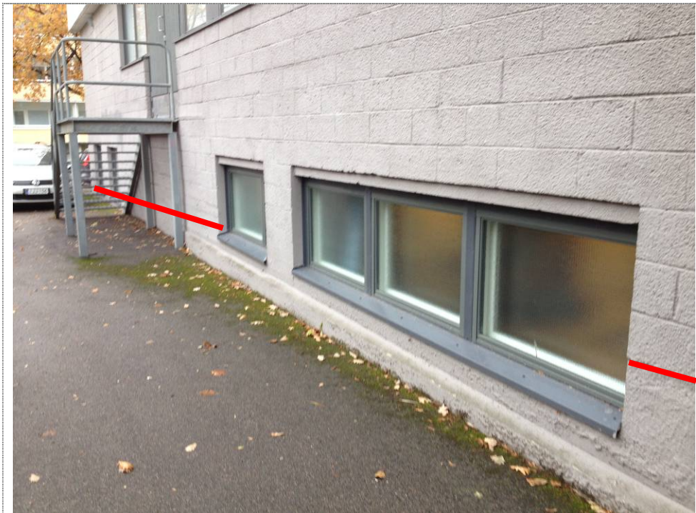
Kuva 21.: Julkisivu iltapäiväkerhon kohdalla. Mineraalivillalla eristetty seinärakenne punaisen viivan alapuolella.
