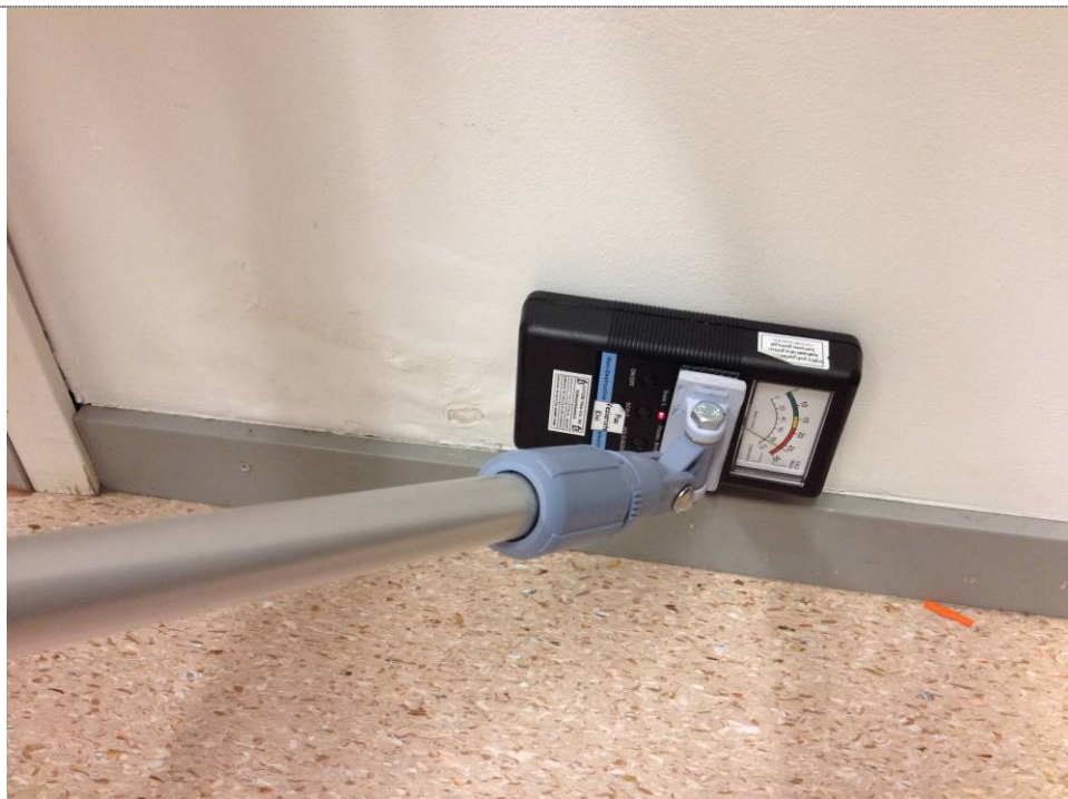
Kuva 12.: Kuvaamataidon väliseinärakenne kostea pintakosteudenosoittimella
