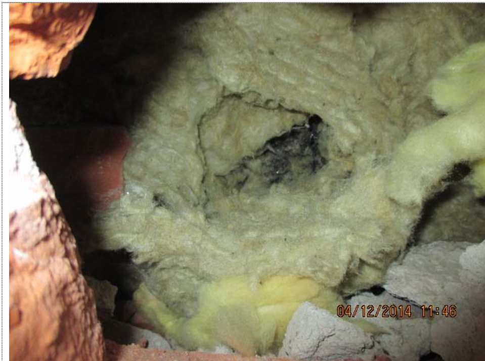
Kuva 19.: Ulkoseinärakenteen lämmöneriste kotitalousluokan sokkelirakenteen kohdalla (maanvastainen rakenne).
