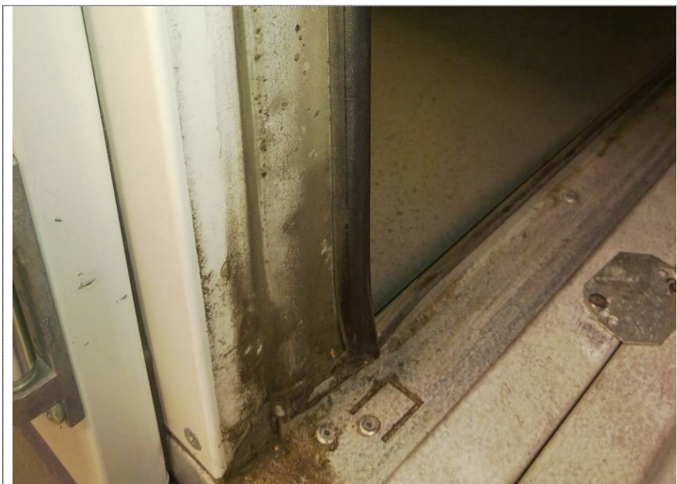
Kuva 25.: Ohivuotoja tulosuodattimelta. Systemaattisesti kaikissa koneissa.
