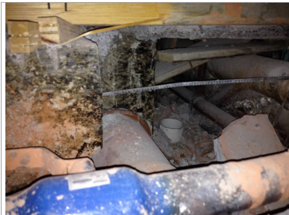
Kuva 4.: Luokan 108 putkikanaalissa orgaanista jätettä ja muottilautoja.
