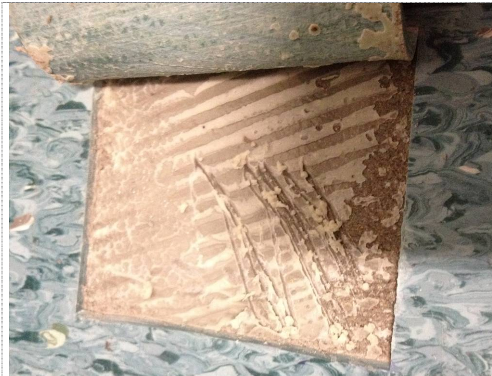
Kuva 9.: Terveystenhoitajan huoneen muovimattopinnoinnien rakenneavaus. Liimoin koostumus poikkeava.
