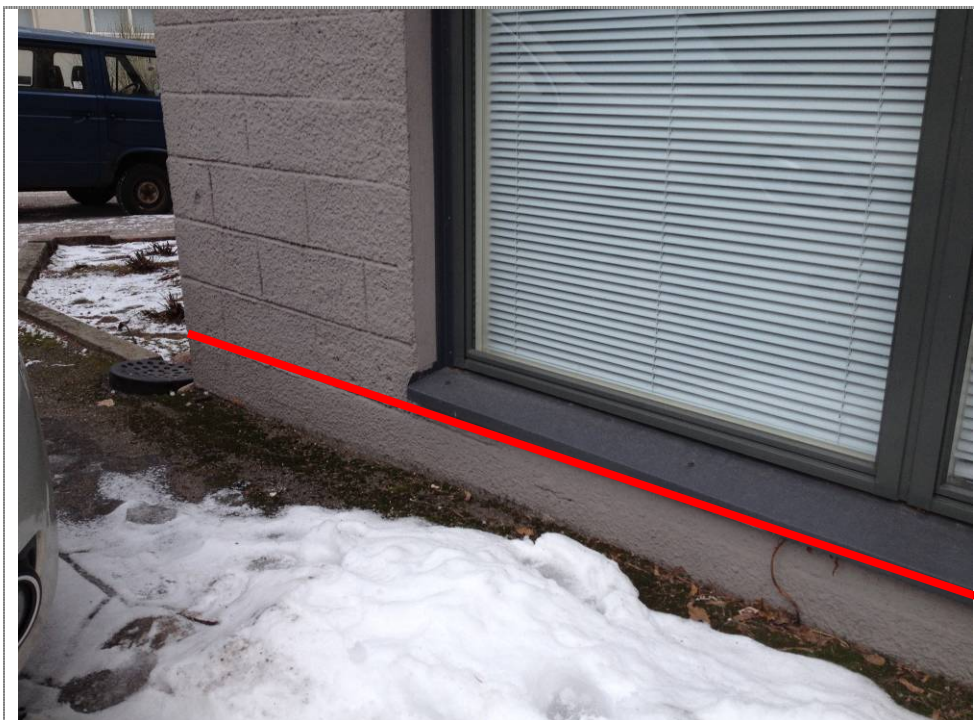
Kuva 20.: Julkisivu kotitalousluokan kohdalla. Mineraalivillalla eristetty seinärakenne punaisen viivan alapuolella.
