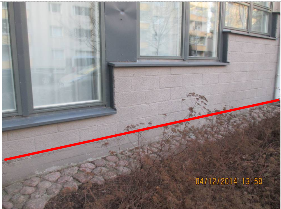
Kuva 18.: Julkisivu auditorion kohdalta. Punaisen viivan alapuolella betonisokkeli, jossa on lämmöneristeenä korkki.
