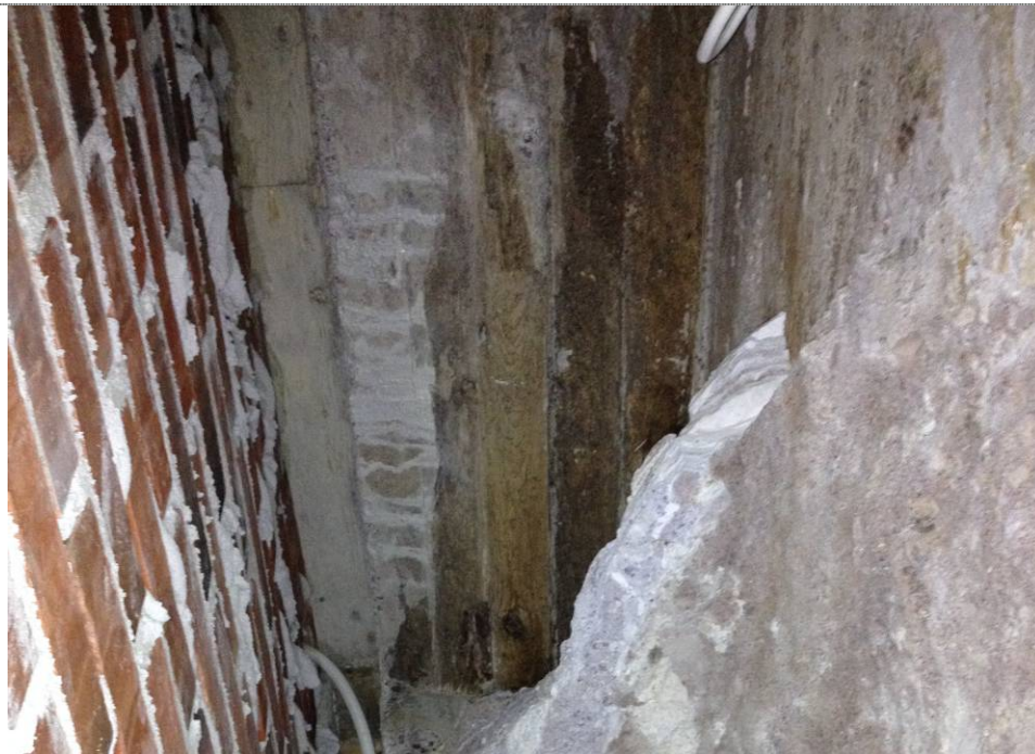
Kuva 16.: Ensimmäisen kerroksen hissien edustan ja portaikon välisessä tilassa muottilautoja
