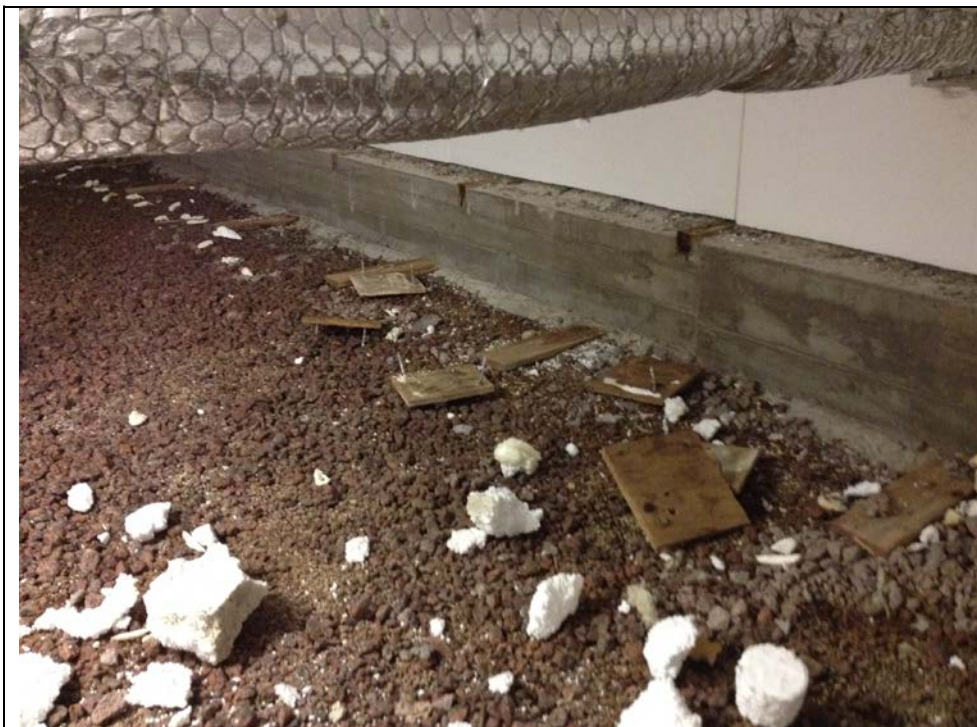
Kuva 1.: Ryömintätilassa orgaanista materiaalia.
