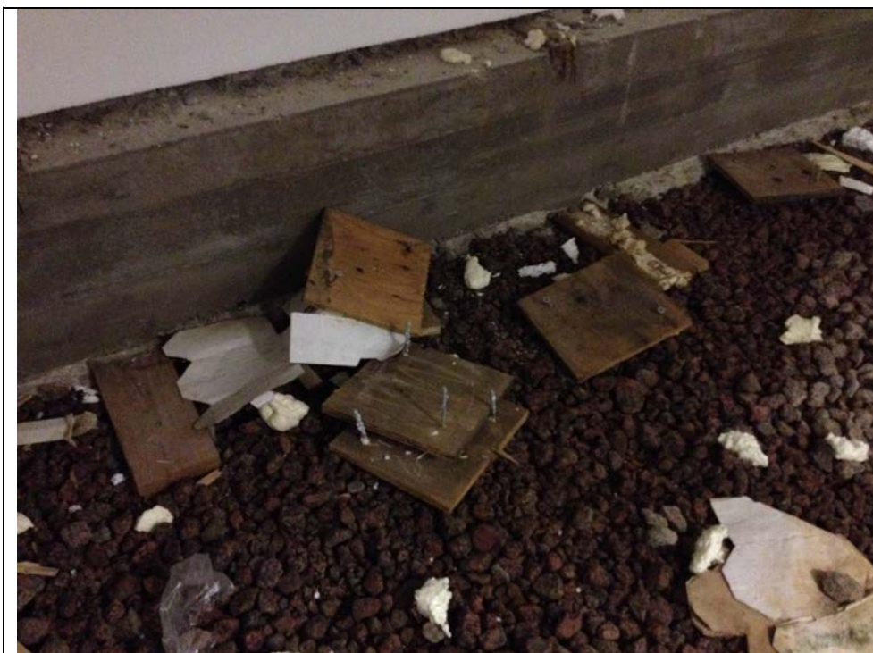
Kuva 2.: Ryömintätilassa orgaanista materiaalia.
