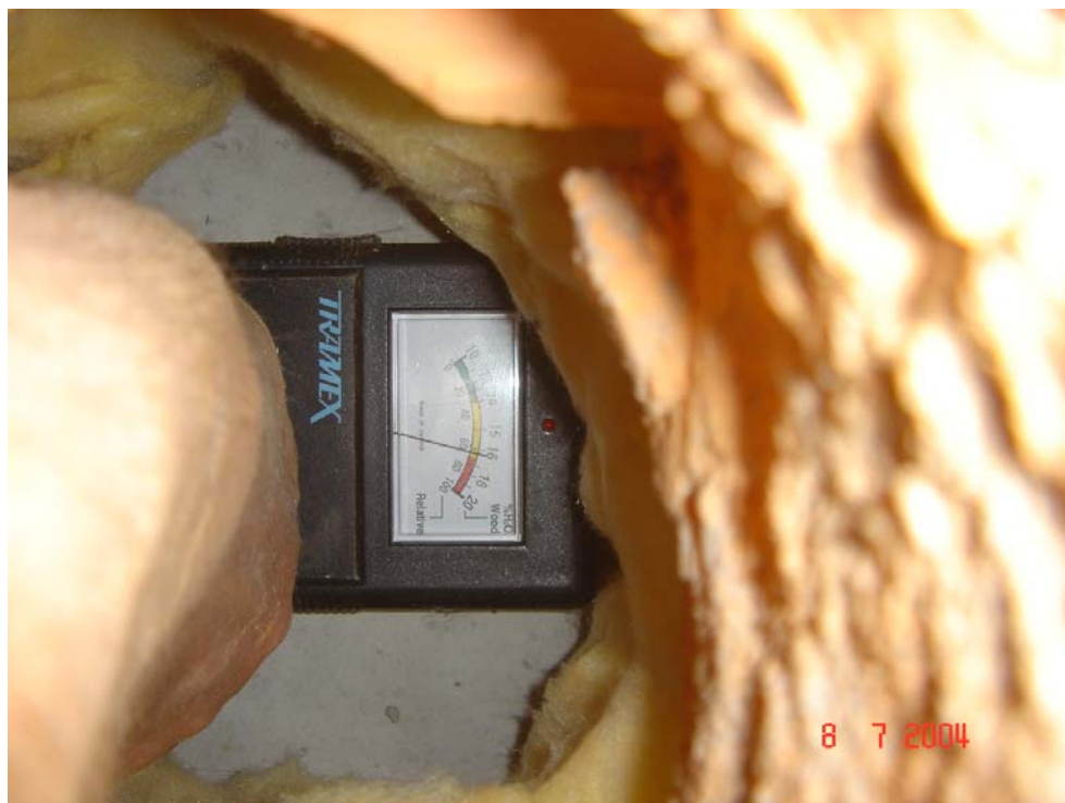
Kuva 3: seinärakenne ruokailutilassa MP 3
