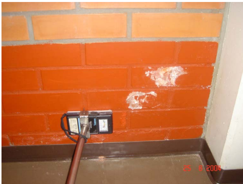
Kuva 5: käytävän seinää keittiön kohdalla
