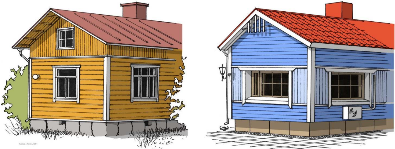
1900-luvun alkupuolen asuintalo ja sama rakennus 2000-luvulla. Tyypillinen esimerkki yksittäisten valintojen aikaansaamasta ei-toivotusta muodonmuutoksesta.
