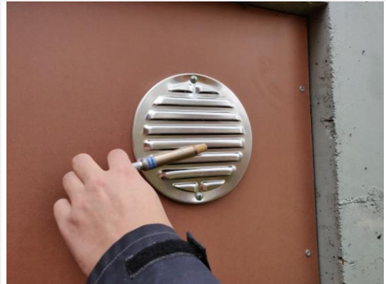
Kuva 7. alapohjaan laskettu merkkiaine kulkeutuu alipaineistuksen kautta ulos.
