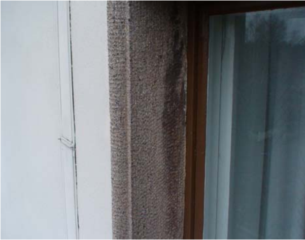
Kuva 7. Ikkunapielen kosteusjälkiä.
