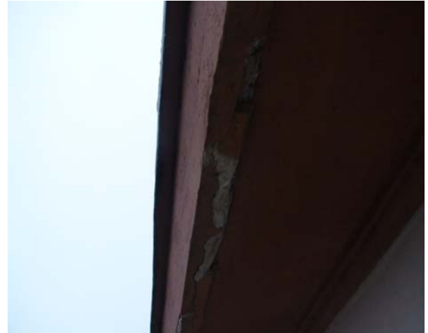
Kuva 10. teräskorroosiovauriota betoniräystäässä.
