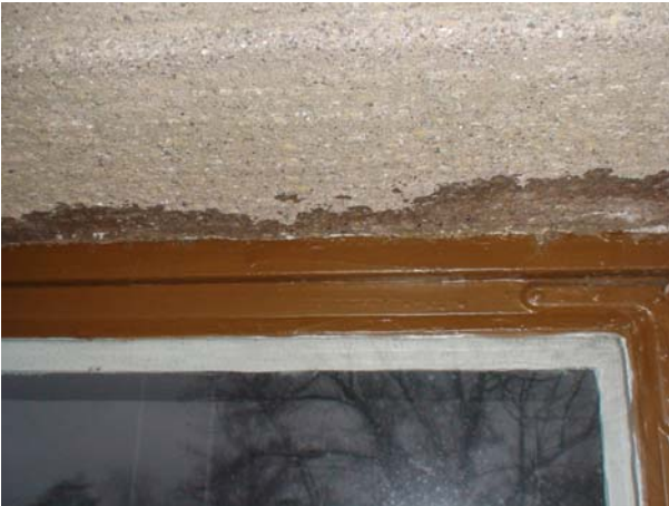
Kuva 8. Ikkunapielen kosteusjälkiä.
