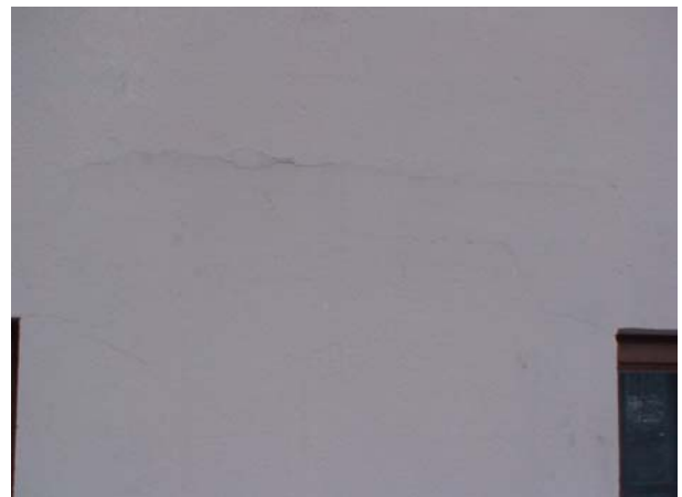
Kuva 6. Halkeamia ja kopoa liikuntasalin ikkunoiden ympärillä.
