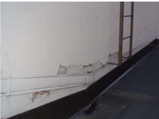
Kuva 9. halkeilua ja kopoa syöksytorven ympärillä.
