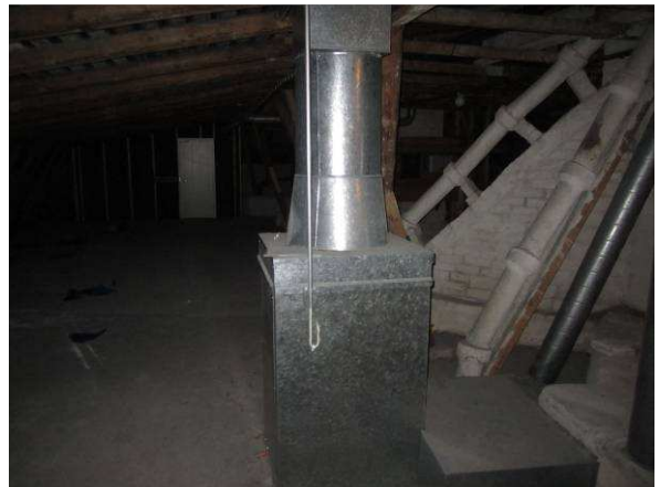
Toinen poistoilmapuhallin
